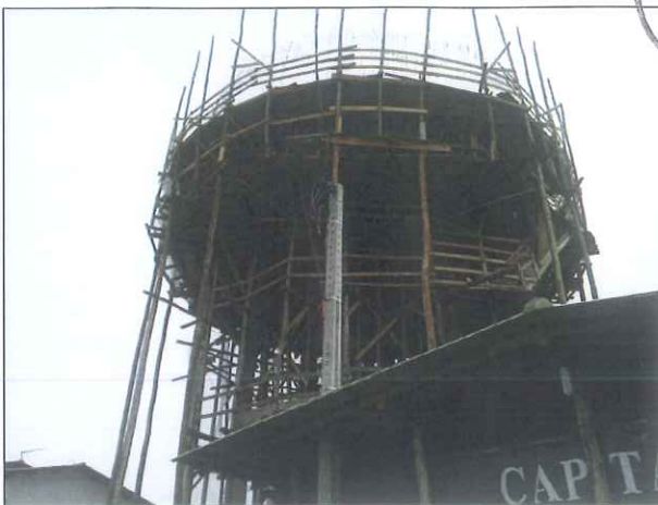
Figura 5: Reservatório elevado em construção
