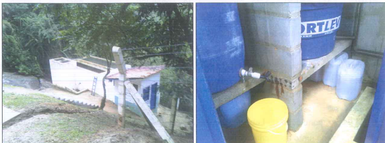
Figura 7: Condições gerais da ETA
