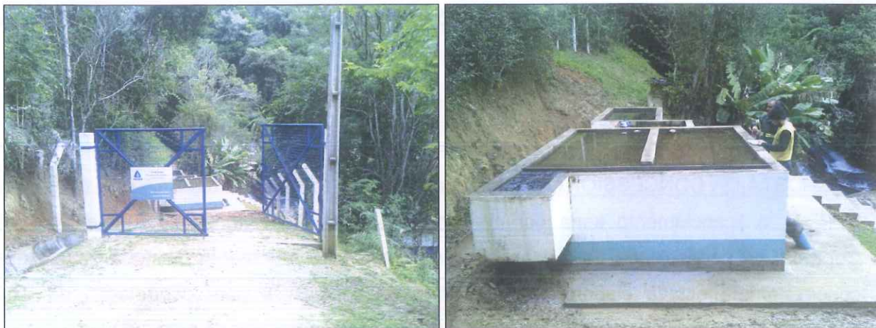
Figura 6: Condições gerais da ETA
