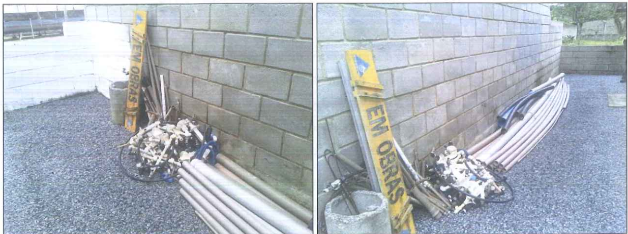
Figura 14: Materiais dispostos em local inadequado
