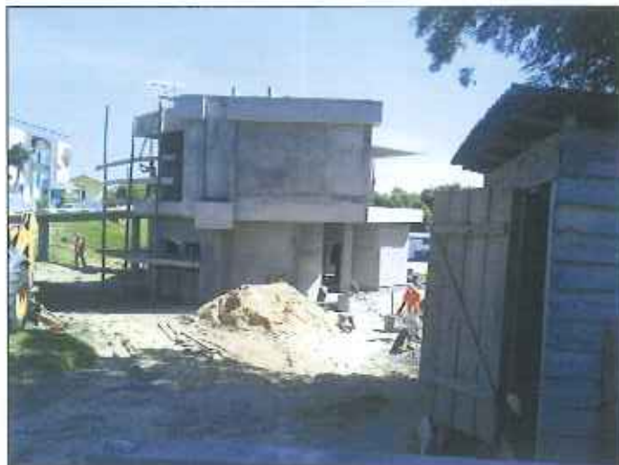
Figura 28: ETA III em obras
