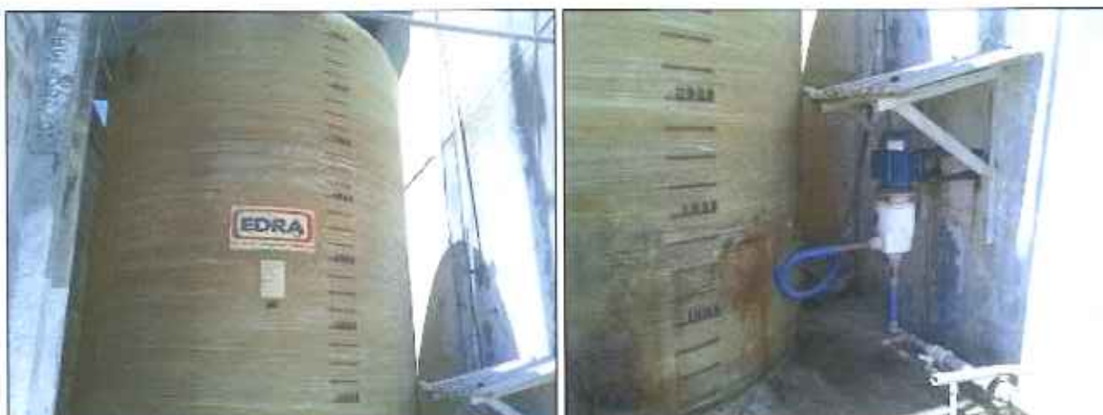
Figura 21: Armazenamento dos produtos químicos
