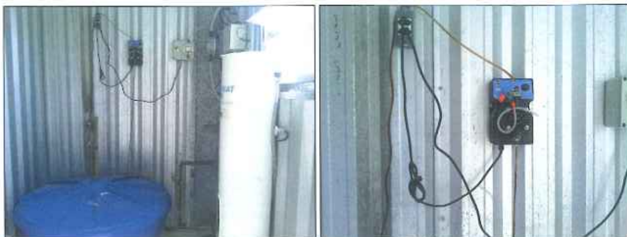
Figura 26: Casa de química da ETA III
