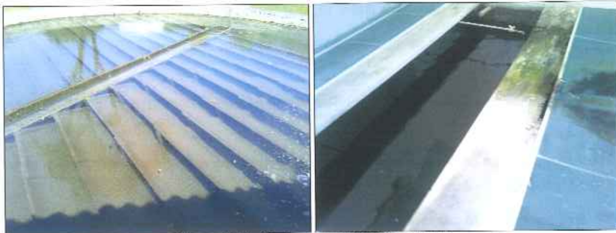
Figura 14: Unidades de tratamento da ETA I
