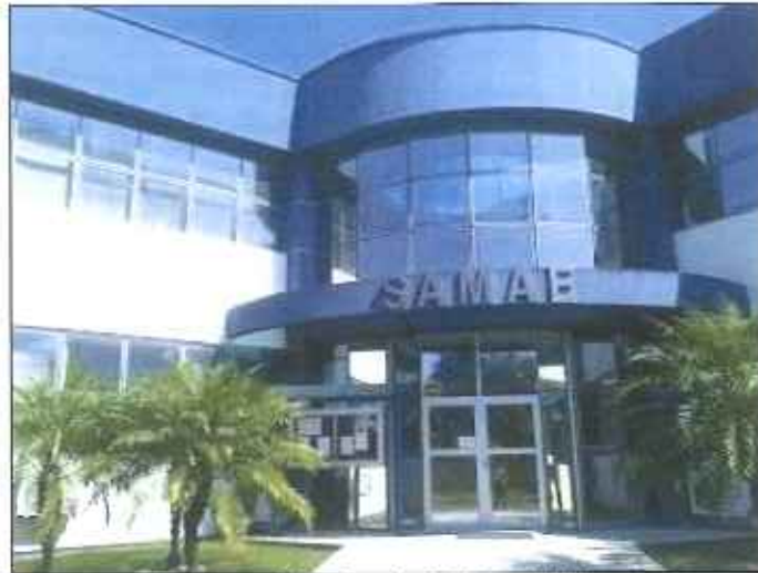
Figura 1: Fachada do Escritório
