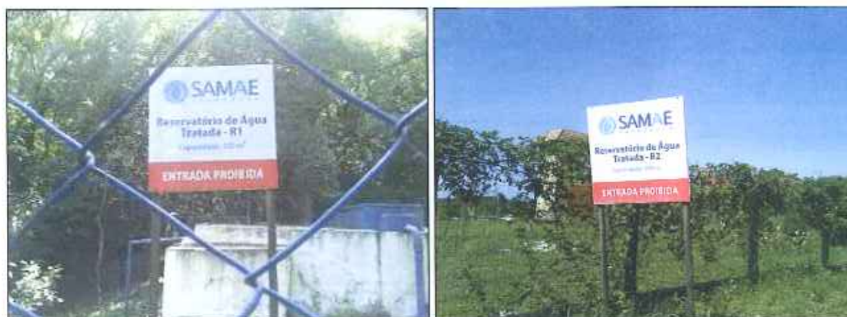
Figura 41: Identificação dos Reservatórios do Morro dos Conventos
