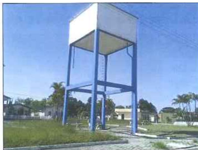
Figura 42: Reservatório Hercílio Luz
