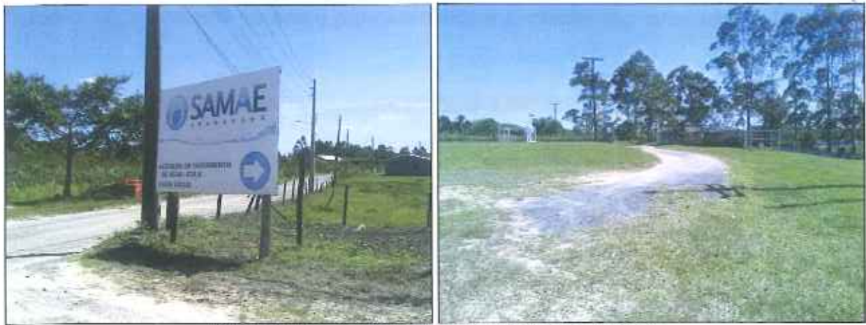
Figura 9: Acesso à área de captação Lagoa da Serra
