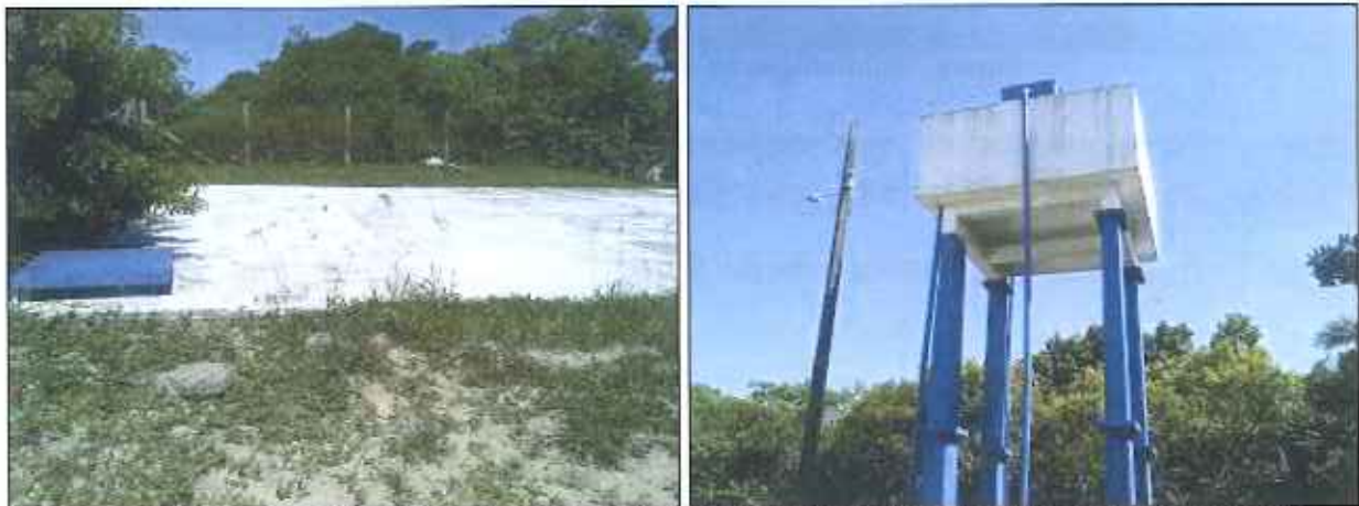
Figura 39: Reservatório R02 enterrado e Reservatório R03 elevado – Morro dos Conventos
