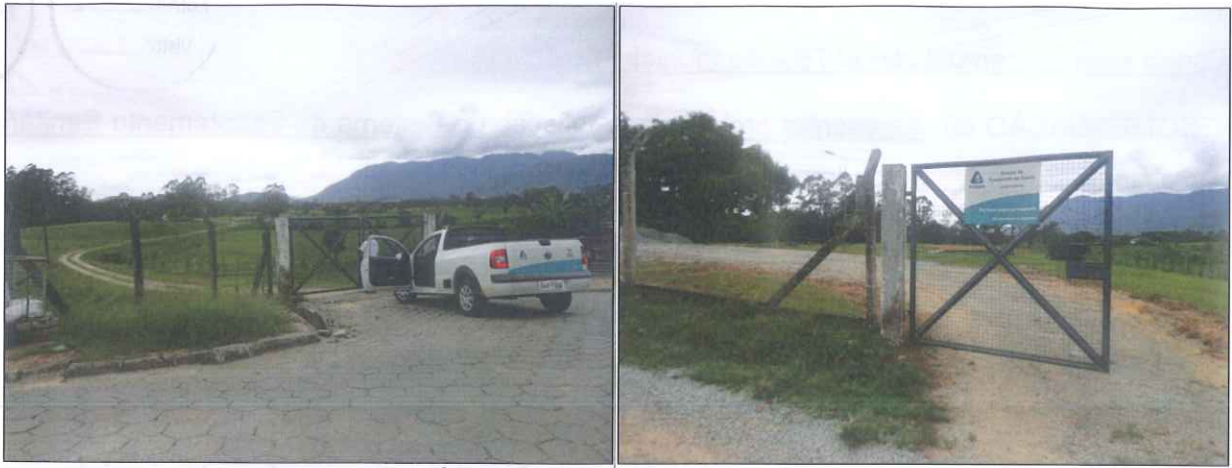
Figura 27: Área de acesso da ETE de Santo Amaro
