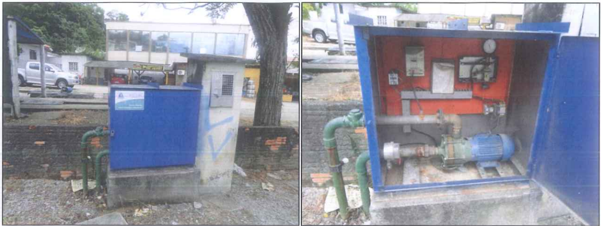
Figura 20: Vista externa e interna do Booster Imbratel
