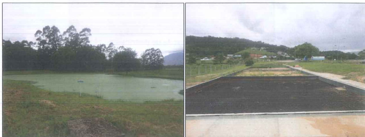
Figura 25: Lagoa de polimento e Leito de secagem
