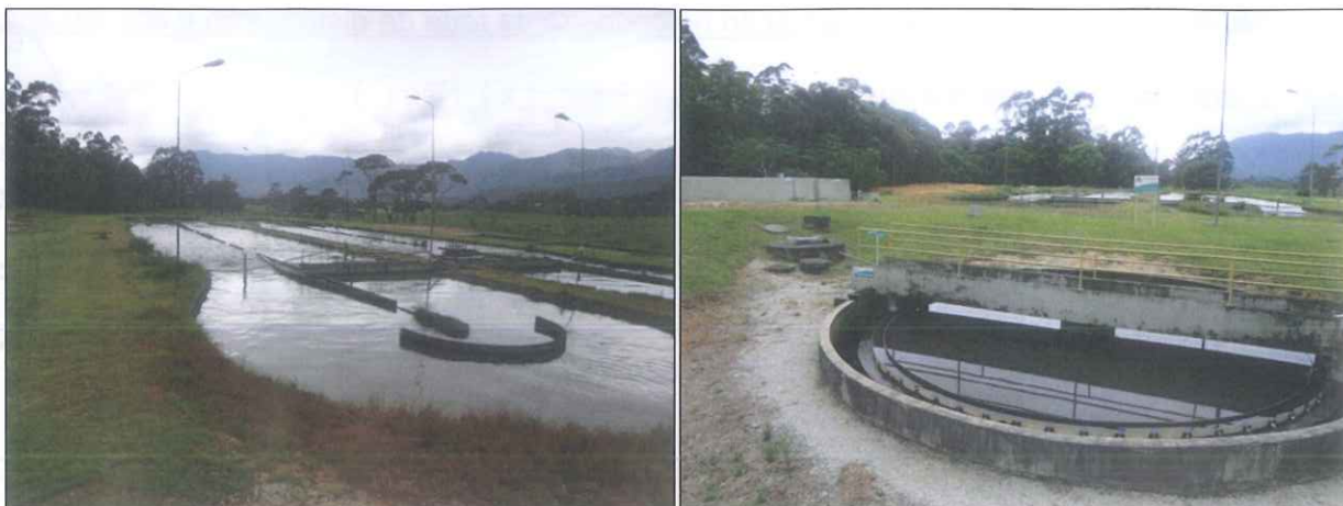
Figura 24: Valo de Oxidação e Decantador secundário
