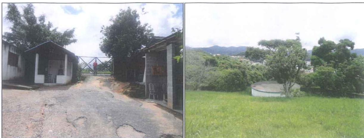
Figura 15: Área de acesso e Reservatório Morro dos Pretos
