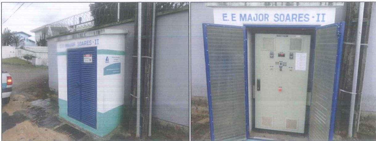
Figura 43: EEE Major Soares II – Vista externa e interna da casa de comando
