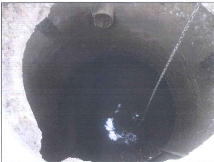
Figura 44: EEE Major Soares 2 – Vista interna do poço úmido
