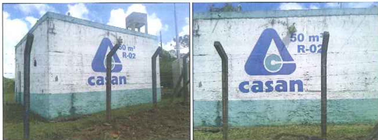
Figura 9: Reservatório R02 – Bela Vista
