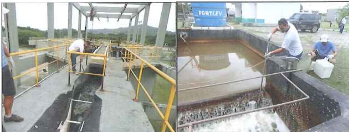
Figura 16: Coleta de amostra dos efluentes bruto e final da ETE Canasvieiras (03/02/2016)
