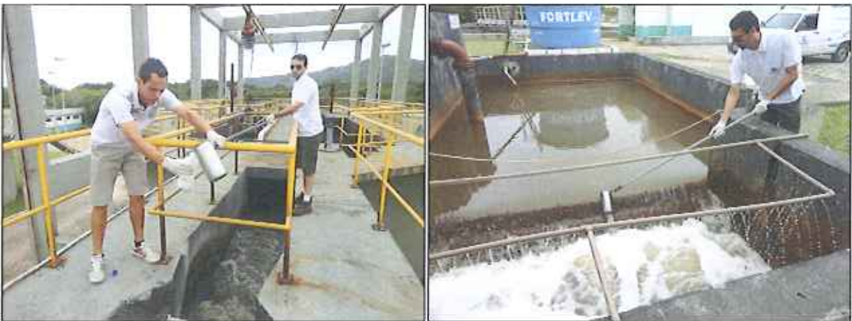
Figura 20: Coleta de amostra dos efluentes bruto e final da ETE Canasvieiras (07/02/2016)
