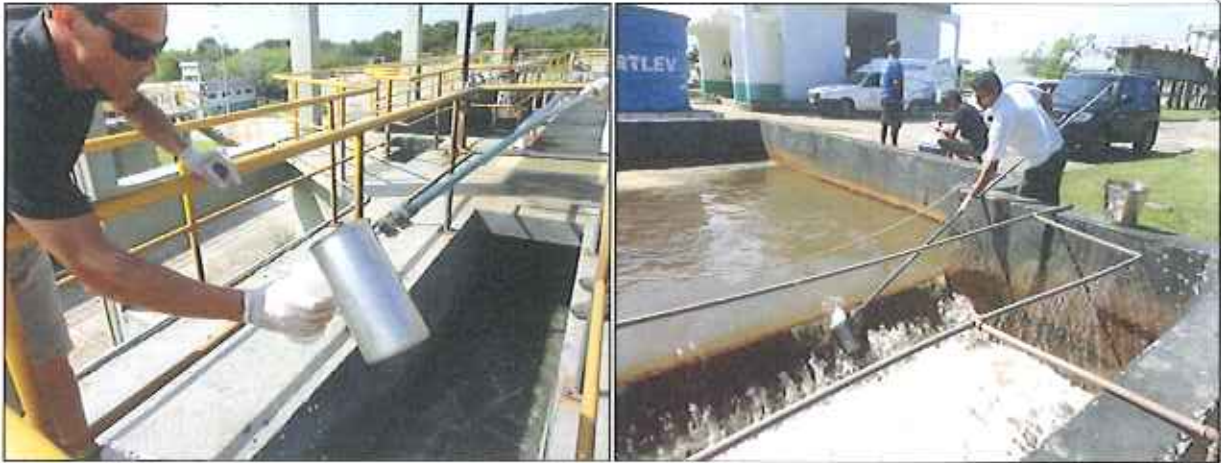
Figura 19: Coleta de amostra dos efluentes bruto e final da ETE Canasvieiras (06/02/2016)
