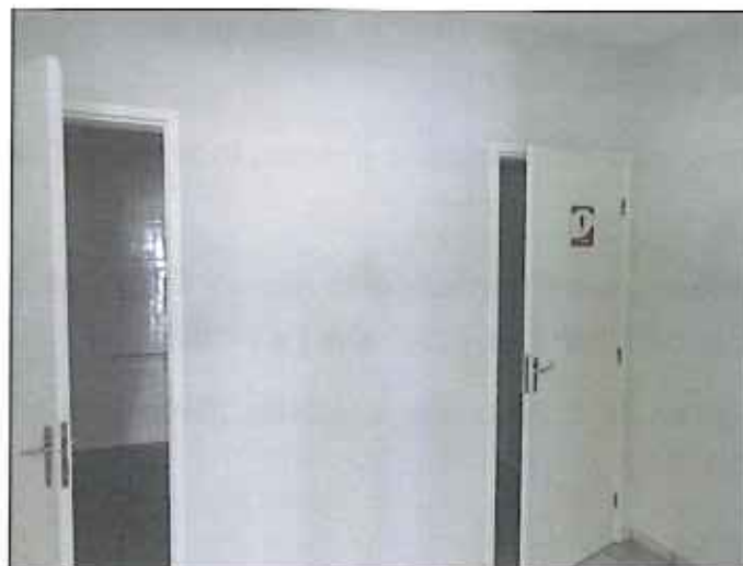
Figura 10: Sanitários para uso coletivo
