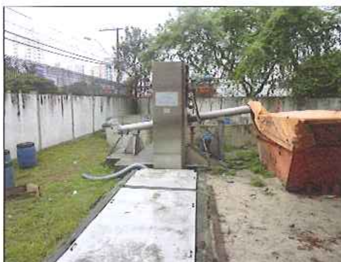
Figura 4: Área interna e externa do poço de chegada da EEE
