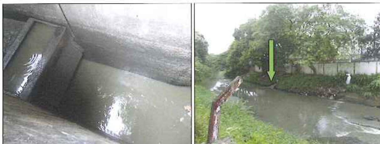
Figura 3: Canal afluente e lançamento direto no rio Araújo
