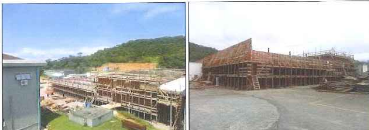
Figura 1: Situação das obras de ampliação da ETA nos meses de Janeiro (à esquerda) e Março (à direita) de 2015
