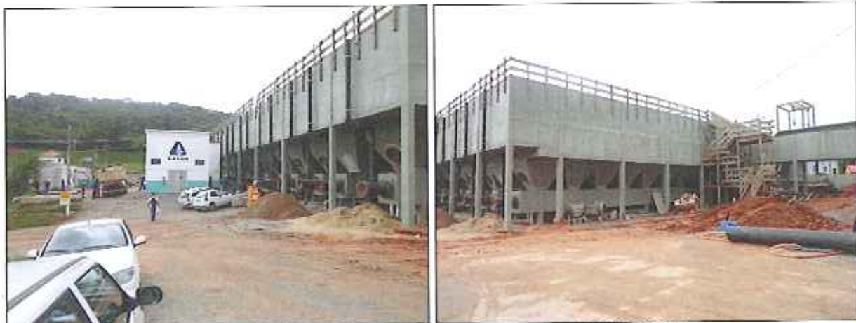
Figura 8: Estrutura do floccodecantador da ETA (06/01/2016)
