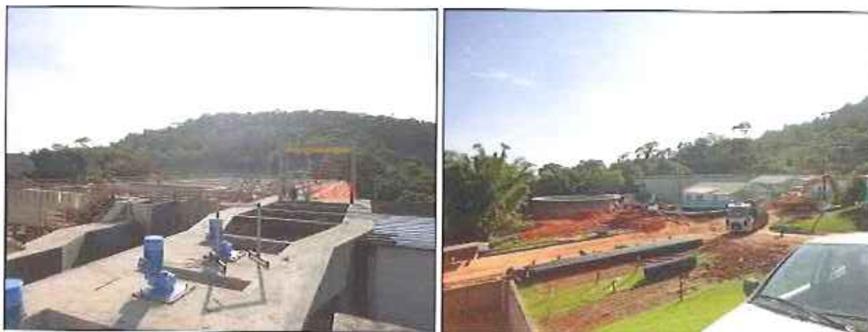
Figura 5: Situação das obras de ampliação da ETA no momento da vistoria do Plano de Emergência (16/12/2015)
