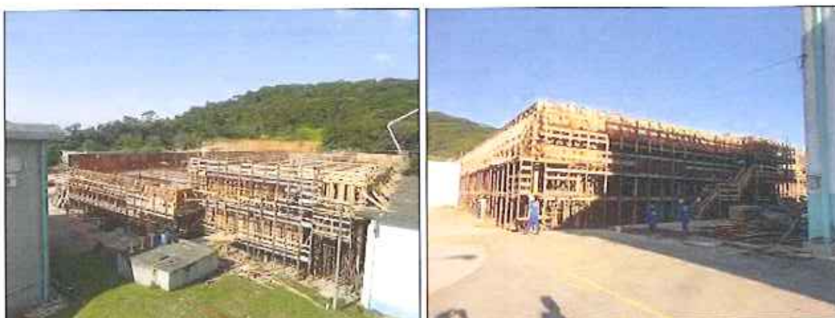
Figura 2: Situação das obras de ampliação da ETA nos meses de Abril (à esquerda) e Junho (à direita) de 2015
