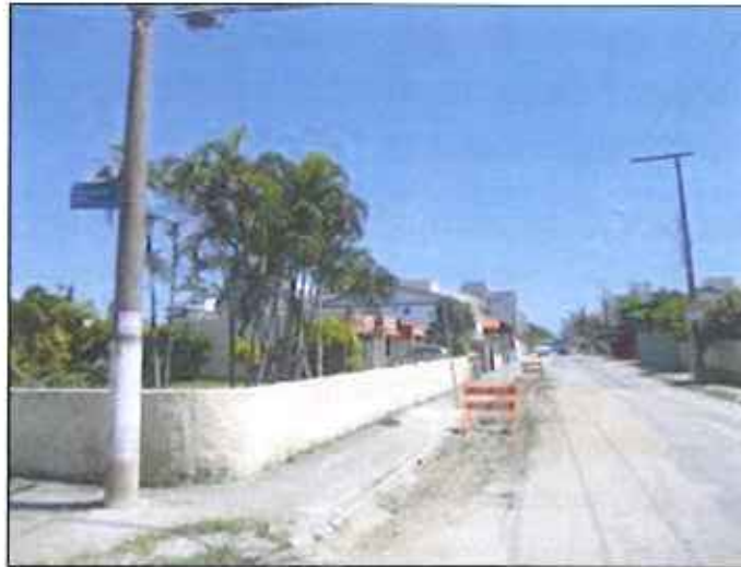
Figura 13: Obras do emissário finalizado na Rua Antônio Heil (25/01/2016)
