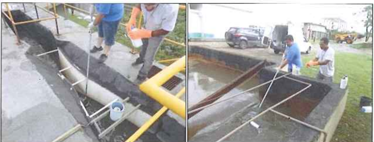
Figura 10: Coleta de amostra dos efluentes bruto e final da ETE Canasvieiras (29/01/2016)
