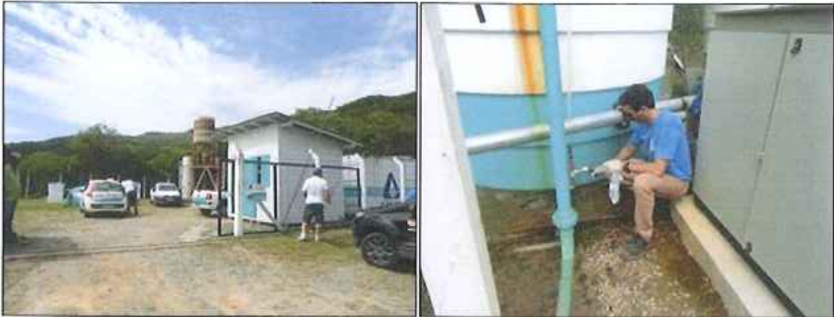
Figura 9: Coleta de amostra de água no reservatório da ETA Compacta Praia Brava na qual somente a desinfecção estava sendo feita
