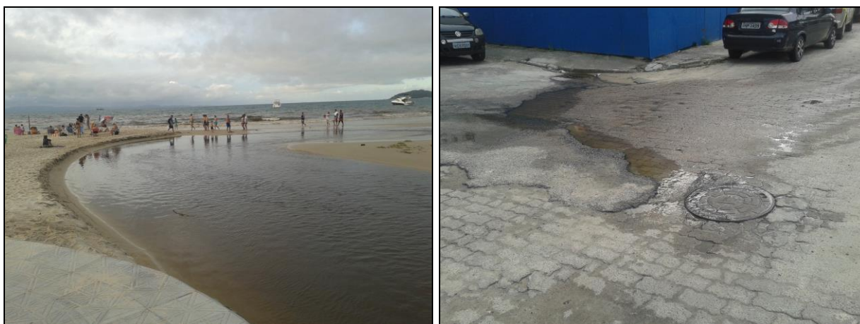
Figura 2: Rio do Braz desaguando na praia de Canasvieiras (à esquerda) e PV da Rua Antenor Borges com vazamento (à direita)
