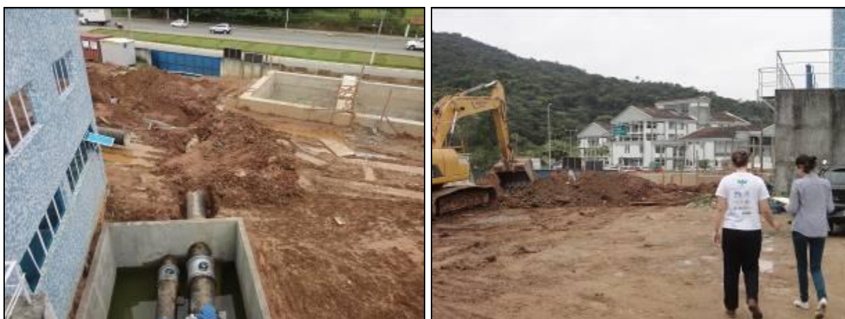
Figura 1: Obras da adutora de 800 mm na área da ETA
