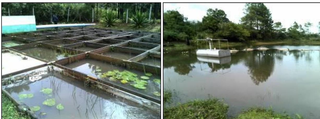
Figura 17: Floculação (à esquerda) e decantação (à direita)
