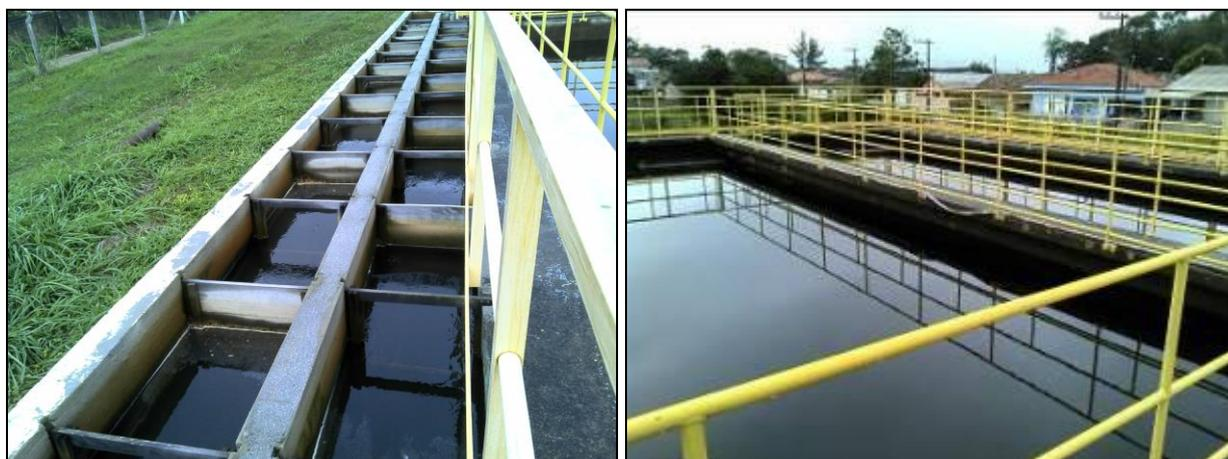
Figura 31: Floculação (à esquerda) e decantação (à direita)
