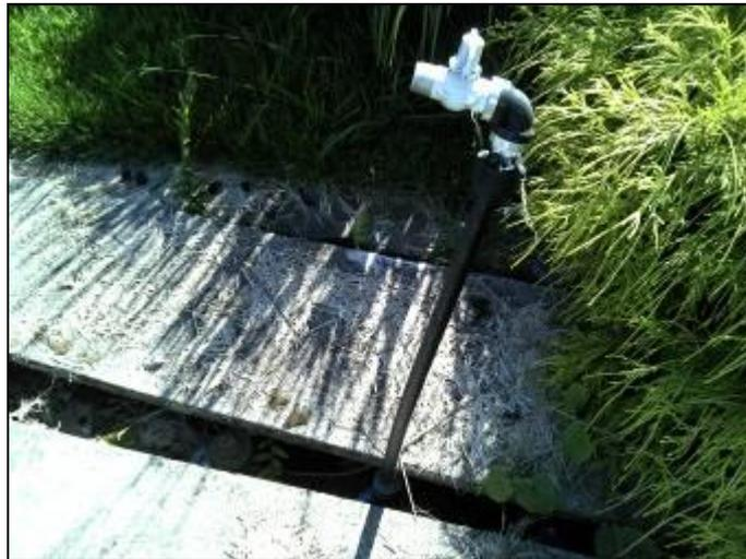
**Figura 9: Poço sem isolamento**
