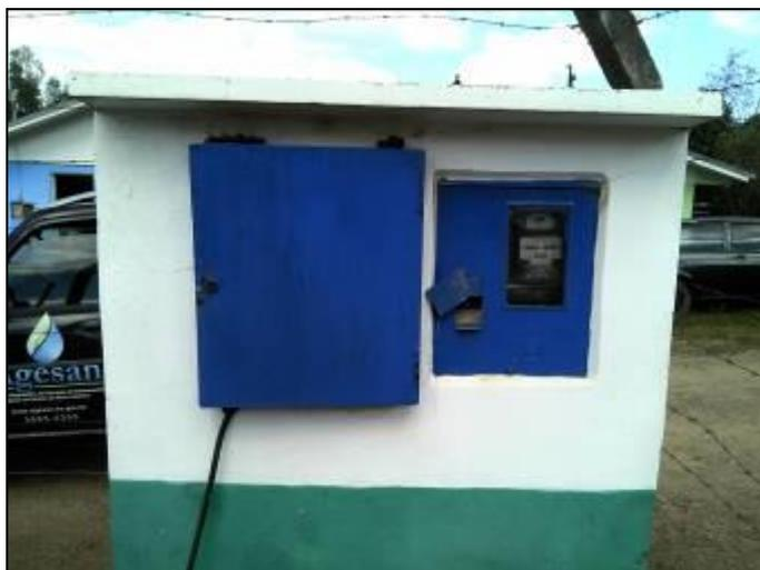
Figura 47: Quadros de comando e de energia desprotegidos
