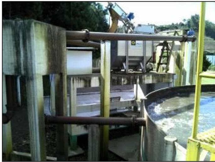
Figura 38: Equipamento de tratamento preliminar
