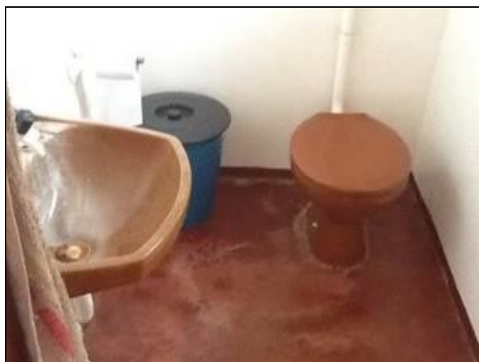
Figura 3: Sanitário de uso coletivo
