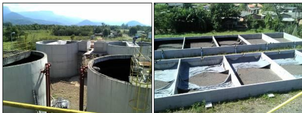
Figura 27: Obras na ETE
