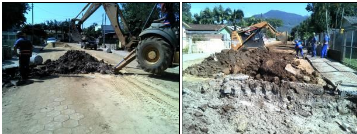
Figura 25: Obras da rede coletora de esgoto e das ligações dos ramais
