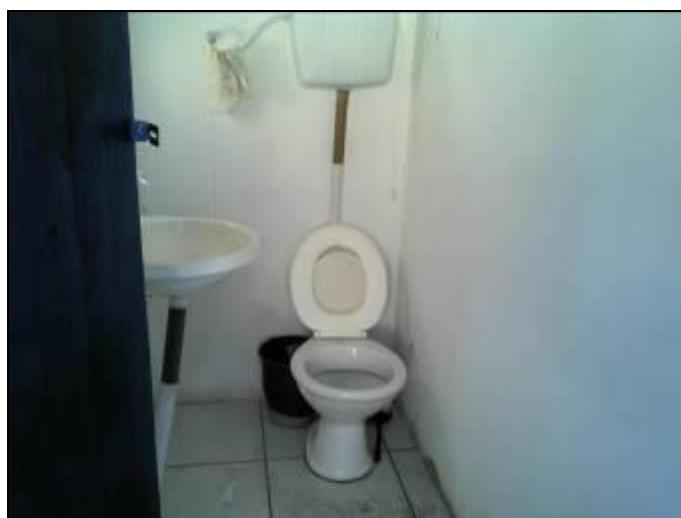
Figura 3: Sanitário da Agencia
