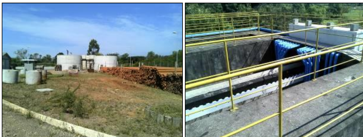
Figura 26: Obras na ETE
