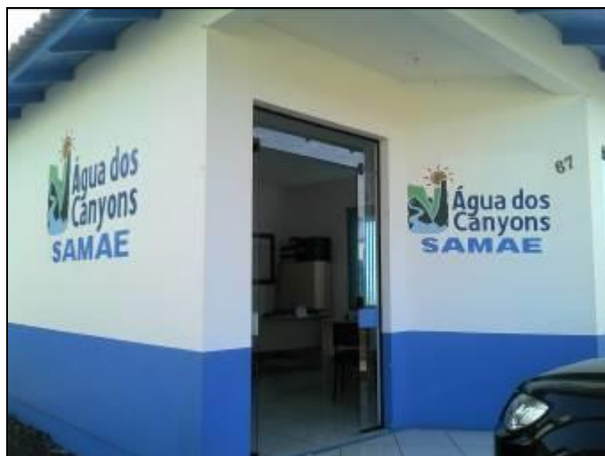
Figura 1: Fachada do Escritório
