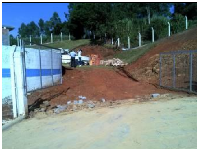
Figura 11: Acesso a ETA
