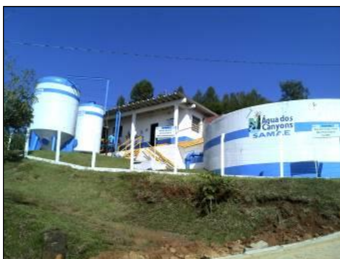
Figura 14: Proteção entorno da ETA
