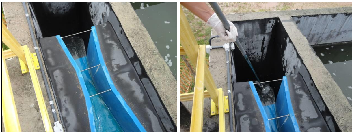
Figura 15: Coleta de amostra de efluente bruto da ETE
