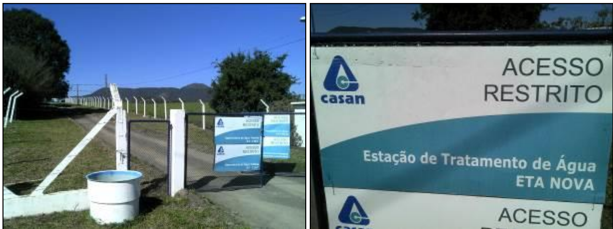
Figura 16: Isolamento e identificação da ETA
