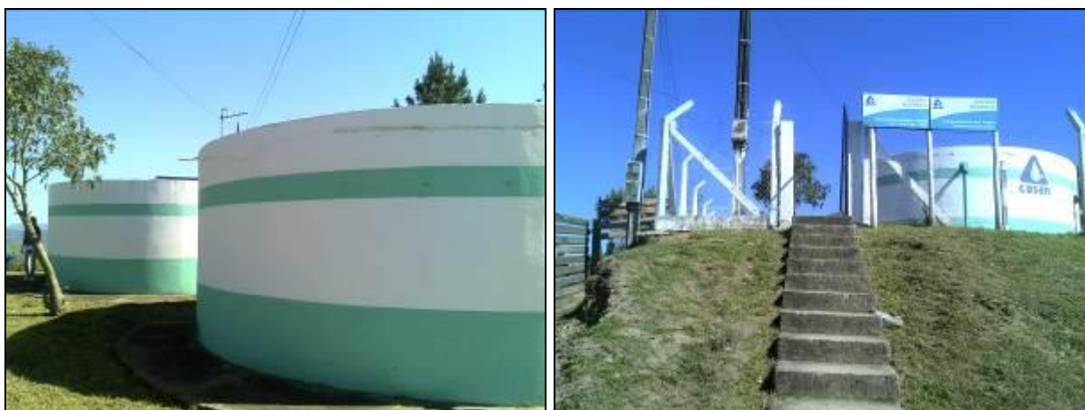
Figura 26: Reservatório 01 - 02 e Acesso
