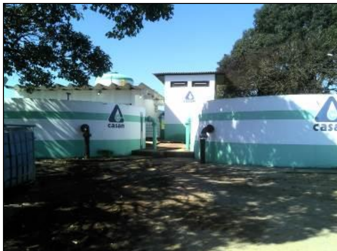
Figura 13: Fachada da ETA e Reservatórios
