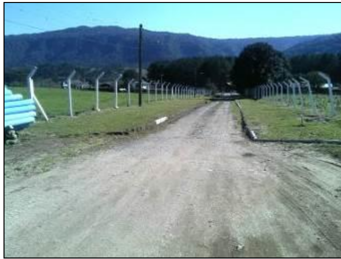
Figura 14: Acesso a ETA
