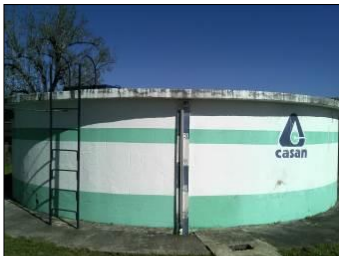
Figura 33: Escada de Acesso ao Reservatório
