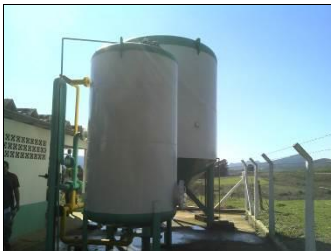
Figura 18: Decantador
