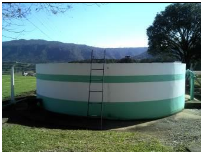
Figura 36: Escada de acesso ao reservatório
