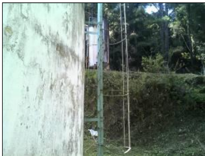
Figura 23: Escada de Acesso ao Reservatório
