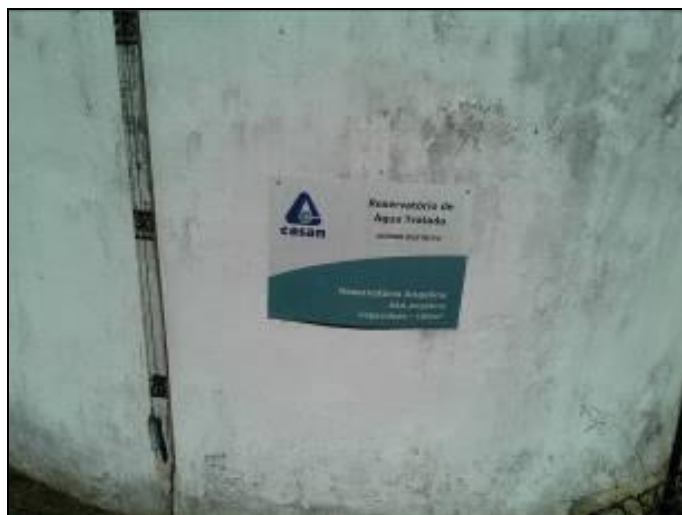
Figura 21: Identificação no reservatório
