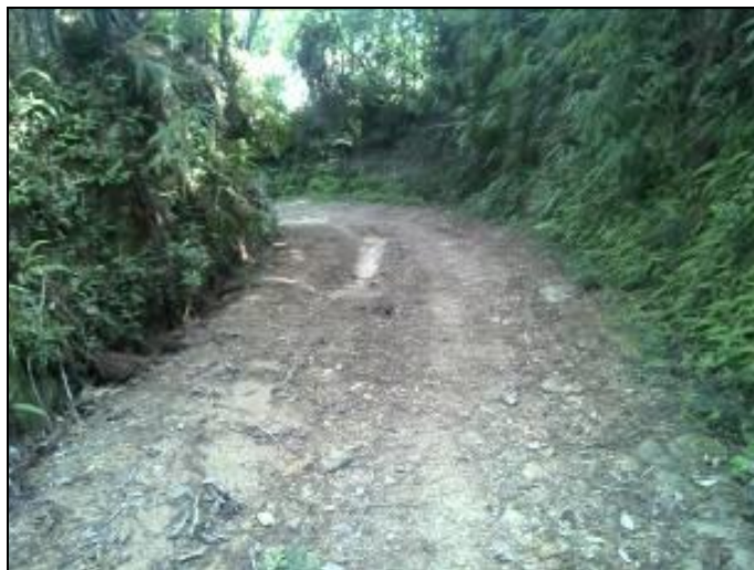
Figura 11: Acesso a ETA
