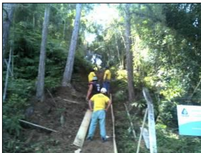
Figura 8: Obras no acesso do manancial
