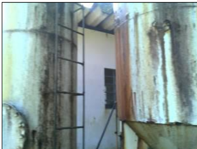
Figura 15: Escada de Acesso
