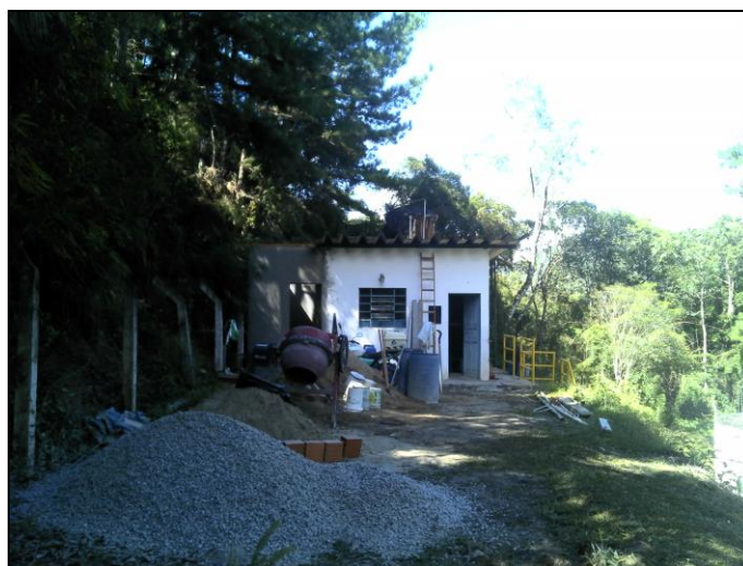
Figura 10: Vista da ETA
