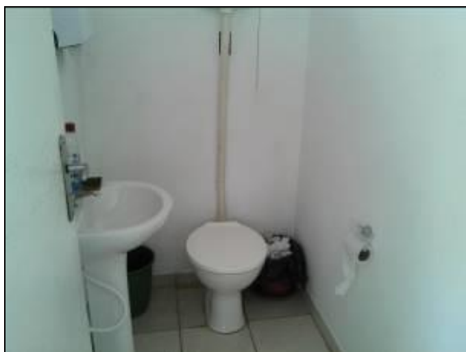
Figura 4: Banheiro do Escritório
