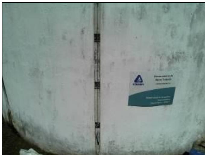
Figura 24: Medidor do reservatório
