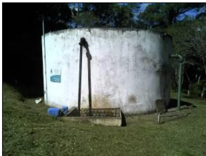
Figura 22: Entorno do reservatório
