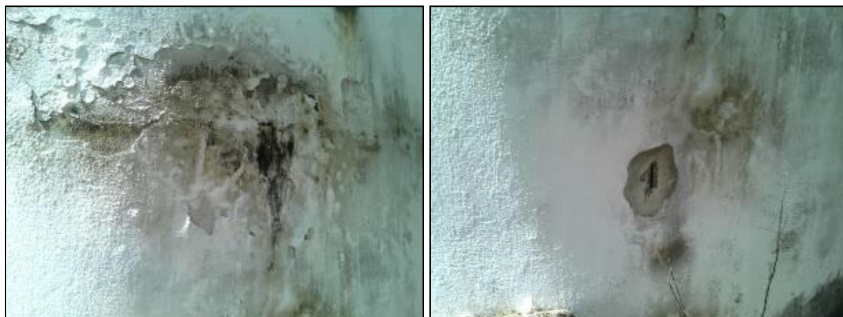
Figura 25: Fotos do Reservatório com infiltrações.
