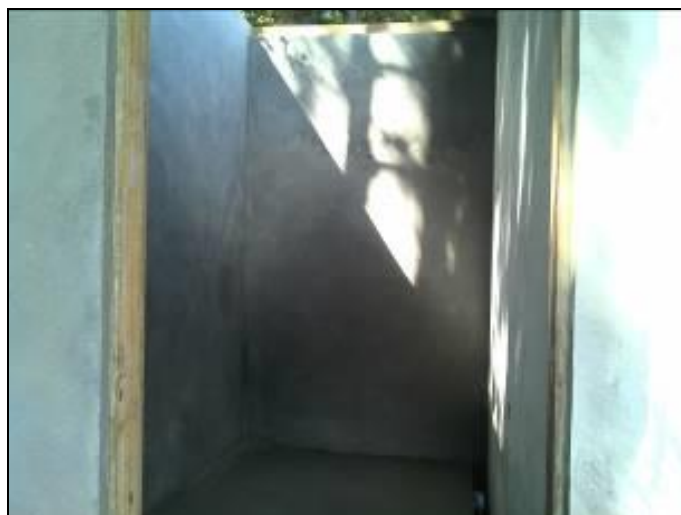
Figura 19: Novo almoxarifado em construção
