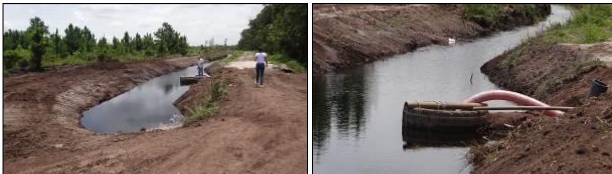
Figura 8: Canal artificial de captação do Rio Pequerê
