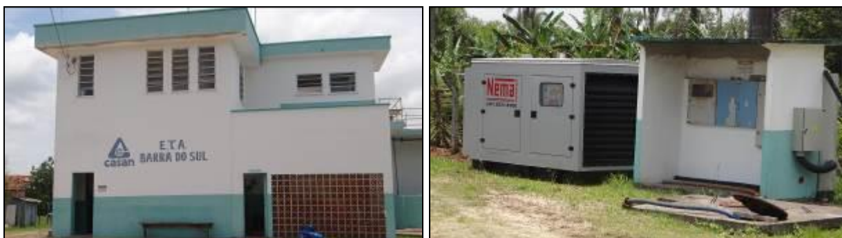
Figura 6: ETA Barra do Sul e gerador disponível
