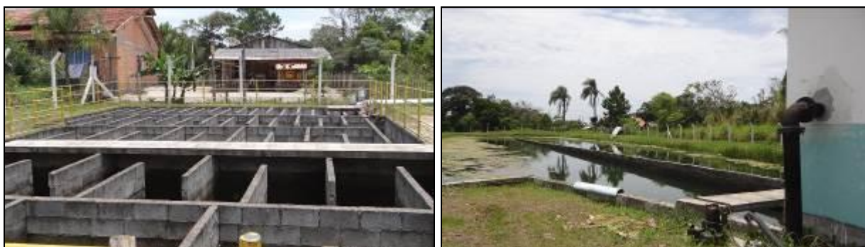
Figura 7: Unidades do tratamento da ETA Barra do Sul
