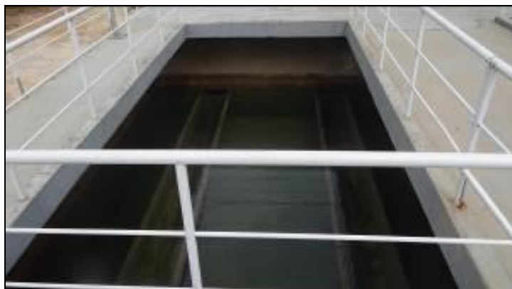
Figura 3: Troca dos leitos filtrantes dos filtros
