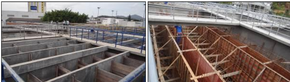
Figura 5: ETA em ampliação – Floculador e decantador
