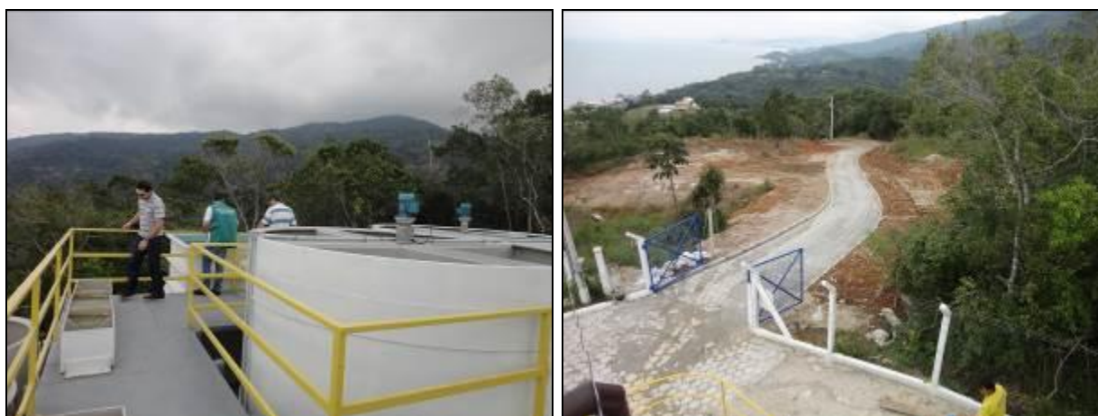
Figura 1: Vista e Acesso a ETA
