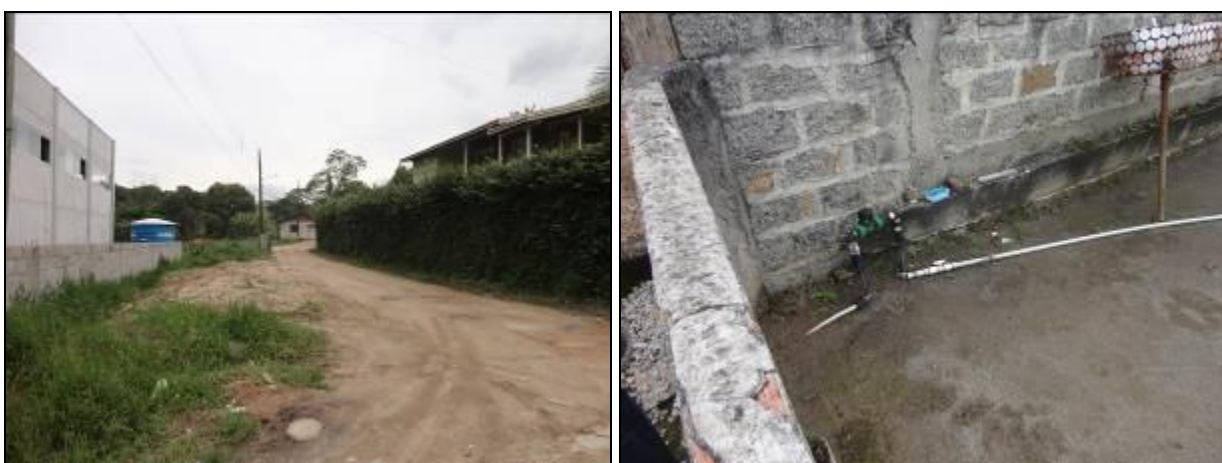
Figura 4: Servidão contemplada com melhorias de Rede de Distribuição e hidrometração
