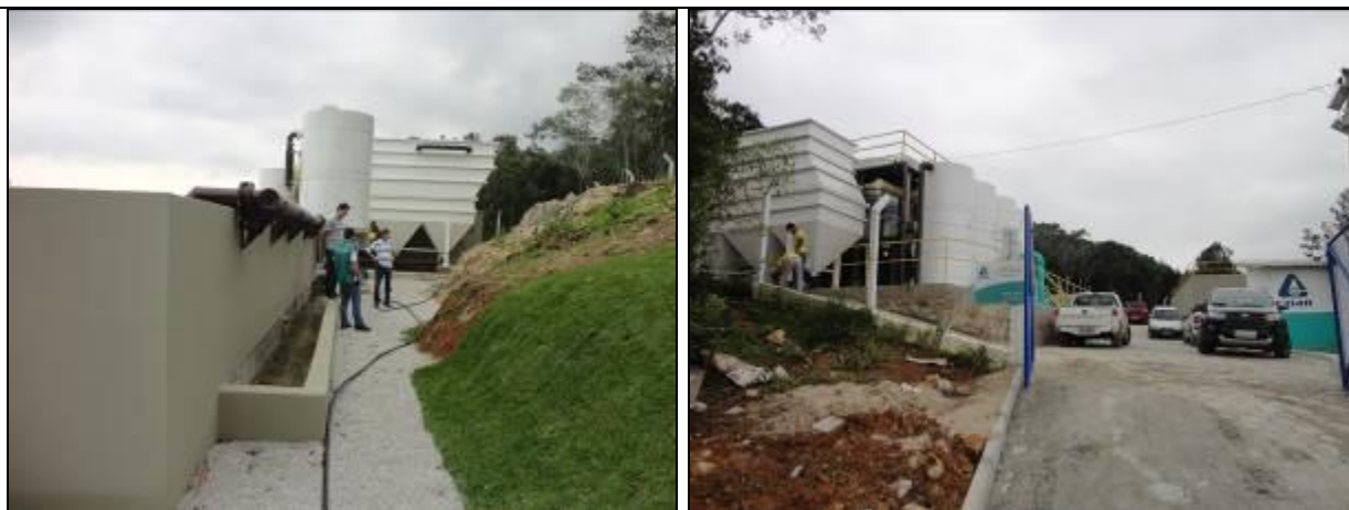
Figura 2: Cobertura de proteção do solo para evitar erosão e Vista Geral da ETA
