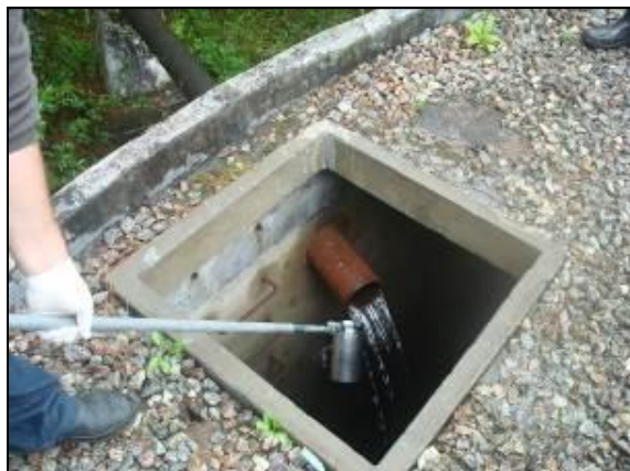
Figura 4: Coleta de amostra de água da Casa de química do Monte Verde (25/06/2014)
