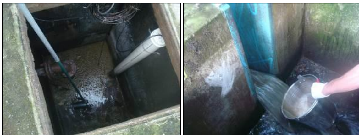
Figura 47: Coleta de amostras de esgoto do efluente bruto e efluente final da ETE Parque Tecnológico (16/06/2014)
