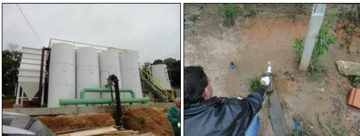
Figura 3: Coleta de água na ETA São Miguel (07/07/2014)
