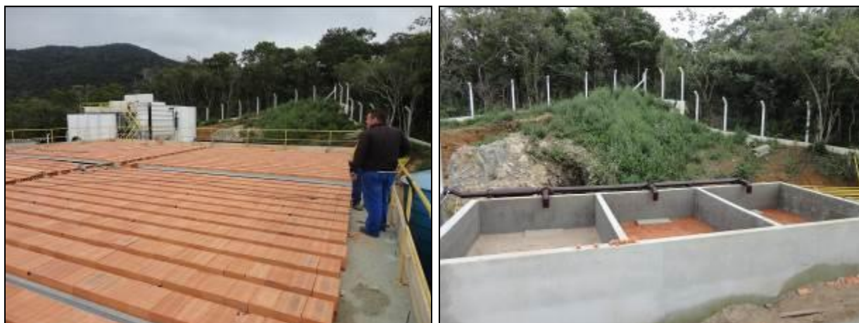
Figura 4: Obras na ETA São Miguel: Cobertura dos reservatórios (à esquerda) e local para realizar a limpeza dos filtros (à direita) (07/07/2014)
