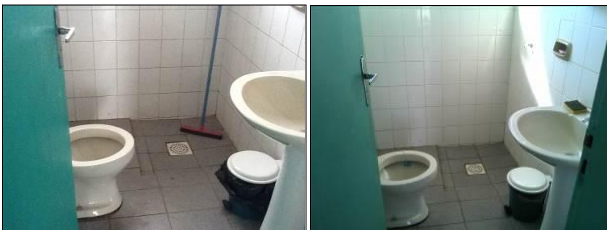
Figura 5: Banheiro do escritório (inicial e acompanhamento)
