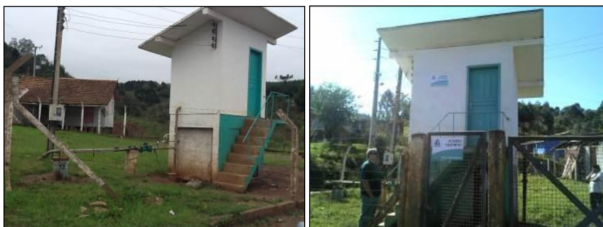
Figura 9: Poço 1 (inicial e acompanhamento)
