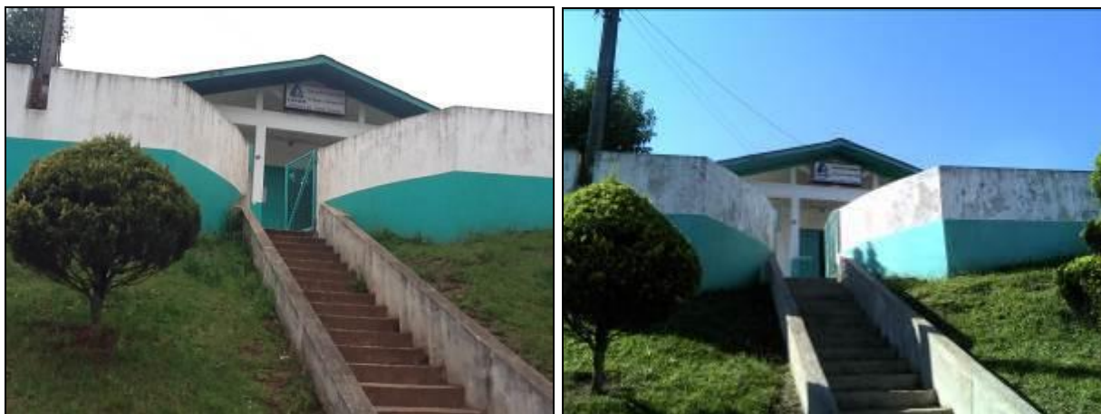
Figura 1: Fachada do Escritório (inicial e acompanhamento)
