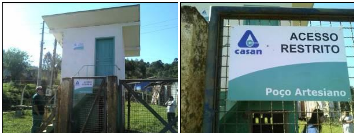
Figura 11: Cercamento e identificação (acompanhamento)
