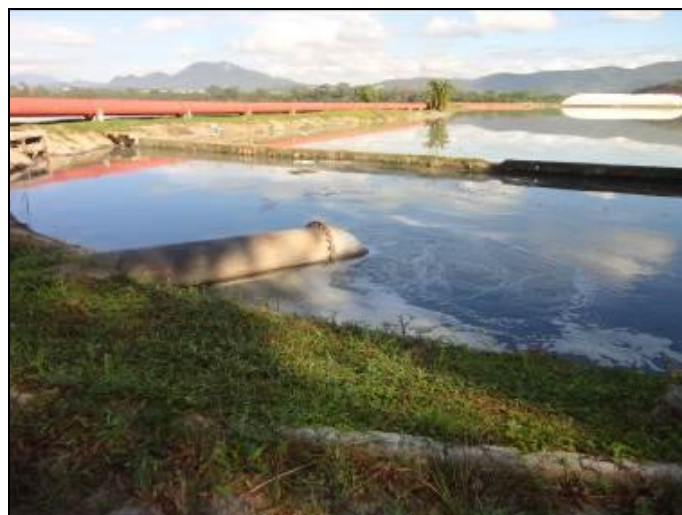
Figura 4: Extravasamento do efluente bruto na lagoa (30/05/2014)
