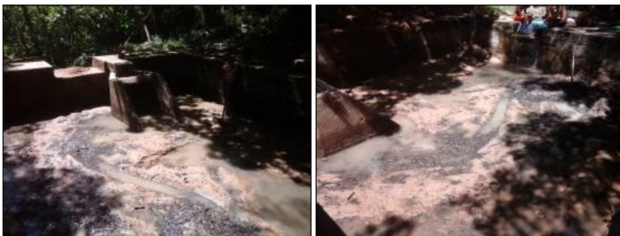
Figura 8: Represa assoreada do manancial do Itacorubi - Quilombo
