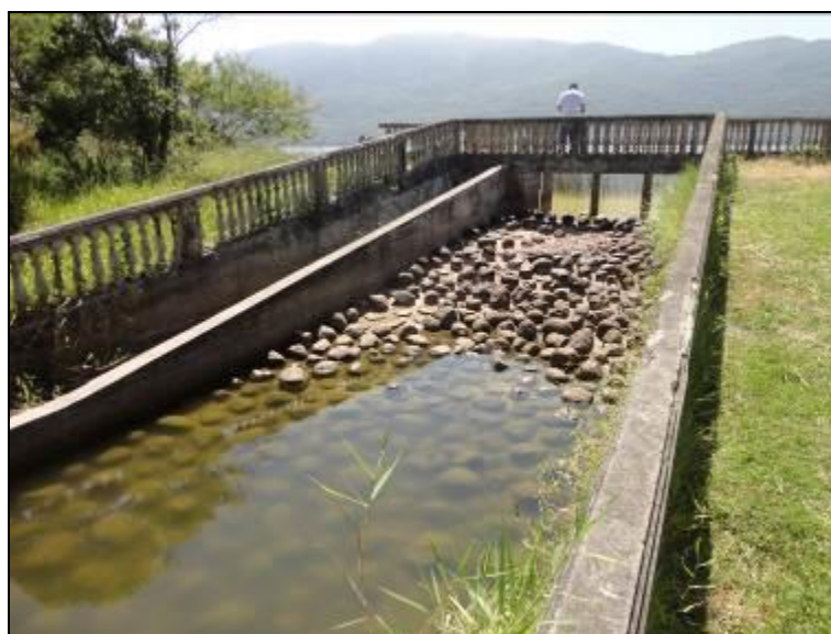
Figura 6: Barragem de nível onde ocorre a captação de água na Lagoa do Peri (10/02/2014)
