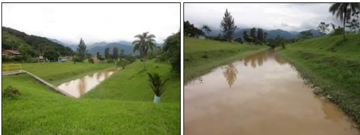
Figura 1: Imagens da área de captação do Rio Cubatão (12/03/2014)
