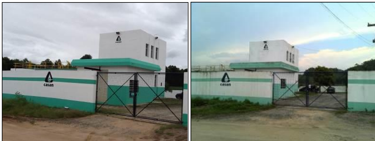
Figura 9: Fachada da ETA (Inicial e acompanhamento)
