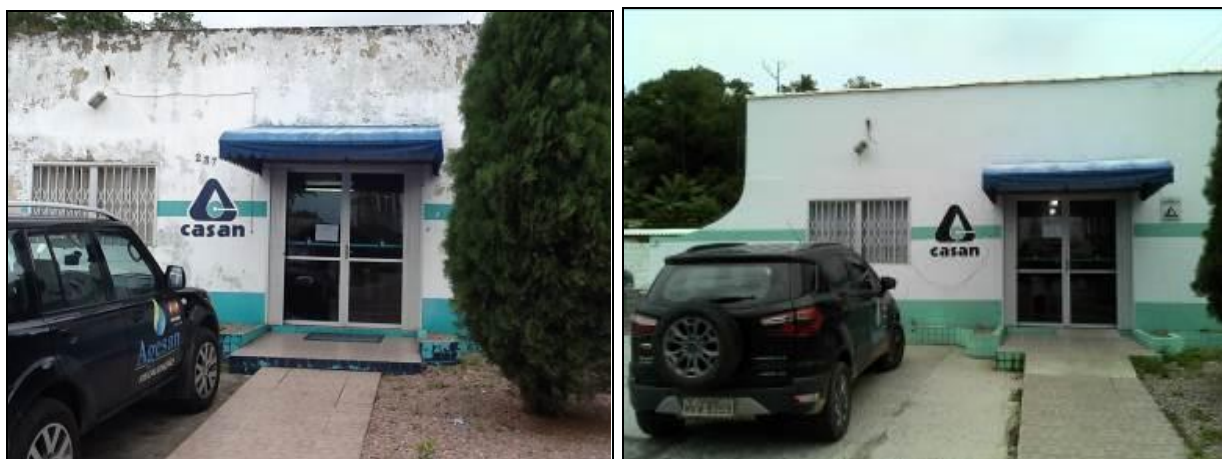
Figura 1: Fachada do Prédio (inicial e acompanhamento)
