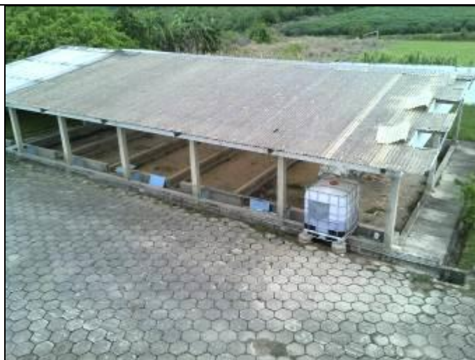
Figura 15: Secagem do lodo (acompanhamento)
