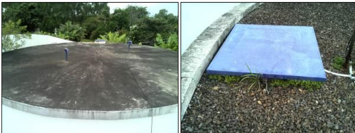
Figura 20: Cobertura dos Reservatórios
