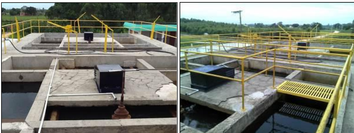
Figura 13: Guarda-corpos da ETA (inicial e acompanhamento)
