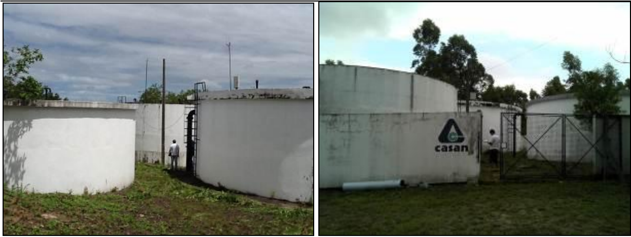
Figura 18: Reservatório Central (inicial e Acompanhamento)
