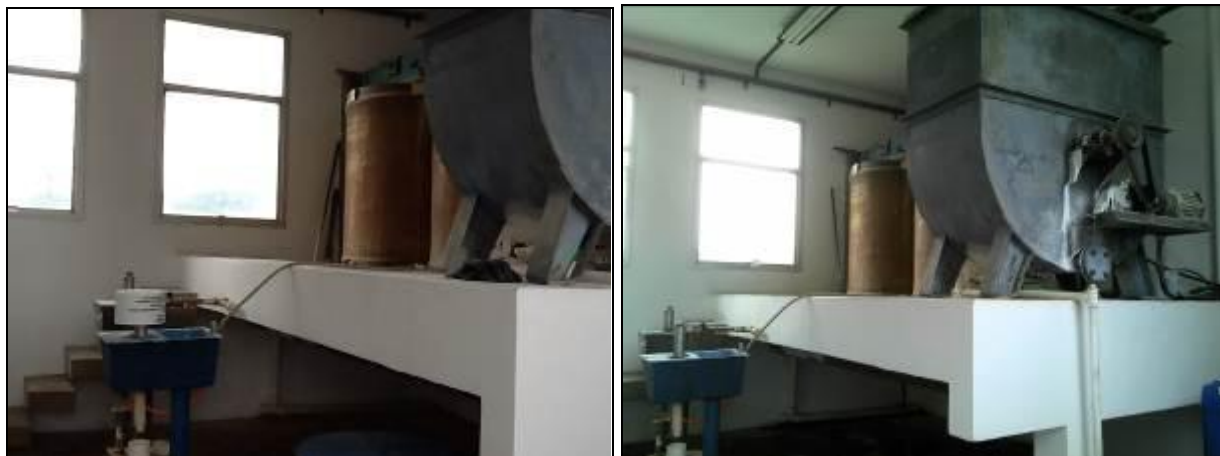
Figura 16: Casa de Química (inicial e acompanhamento)
