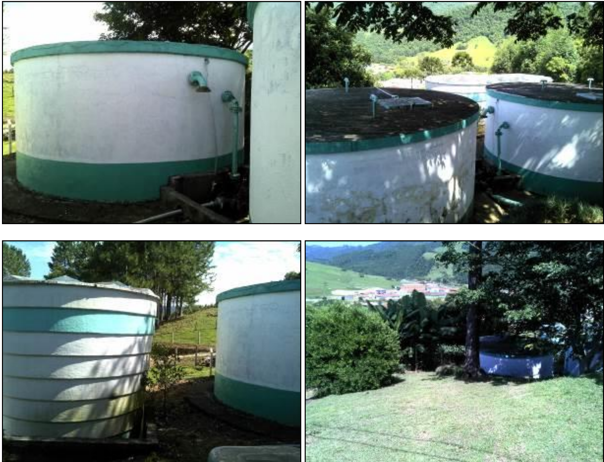
Figura 14 – Reservatórios junto a ETA
