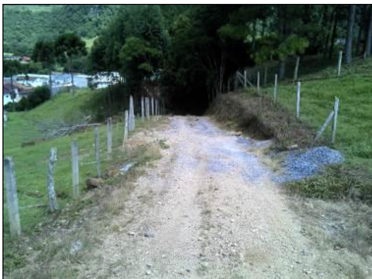
Figura 7 - Acesso a ETA
