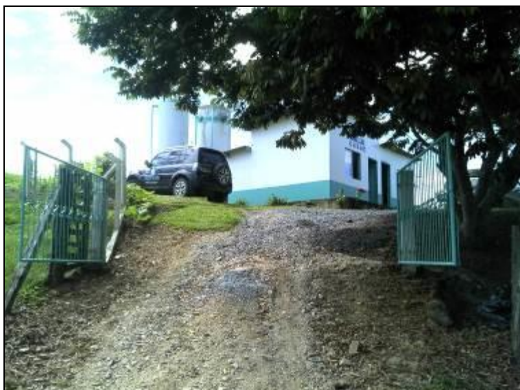
Figura 10 - Entorno da ETA - Protegida
