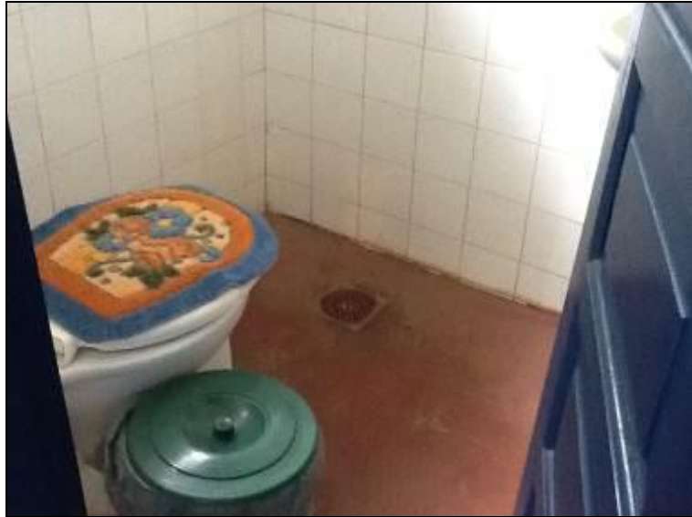
Figura 4: Sanitários da Unidade
