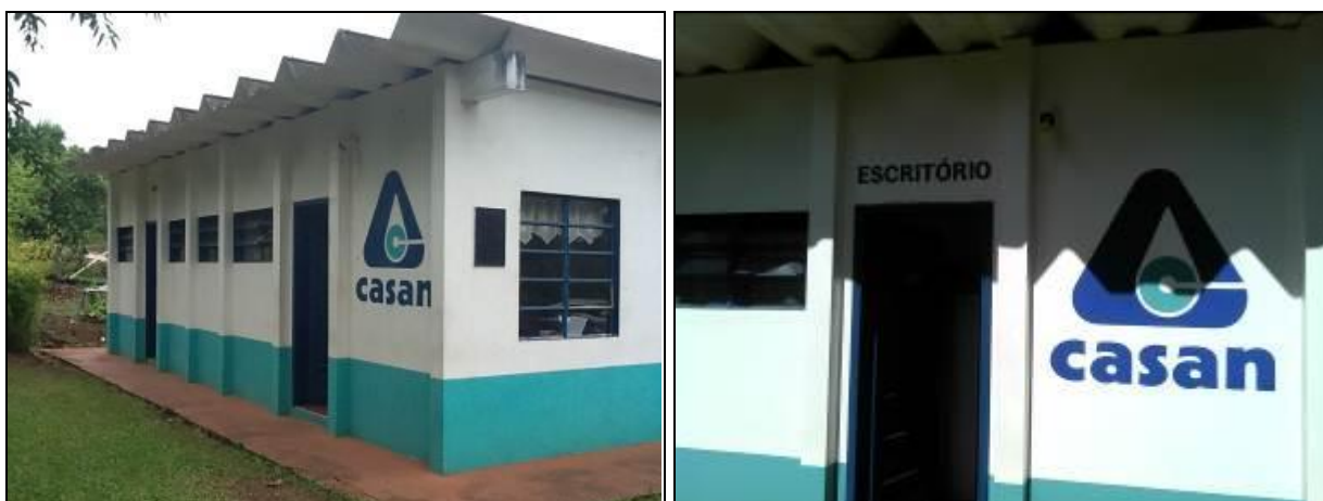
Figura 1: Fachada da Sede da Casan (inicial e acompanhamento)
