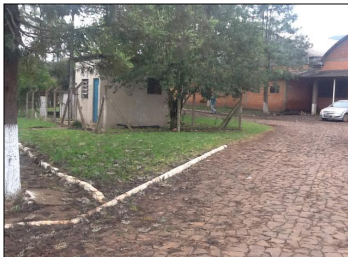
Figura 9: Acesso a captação
