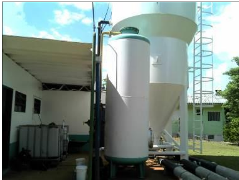
Figura 13: Área externa da ETA (acompanhamento)
