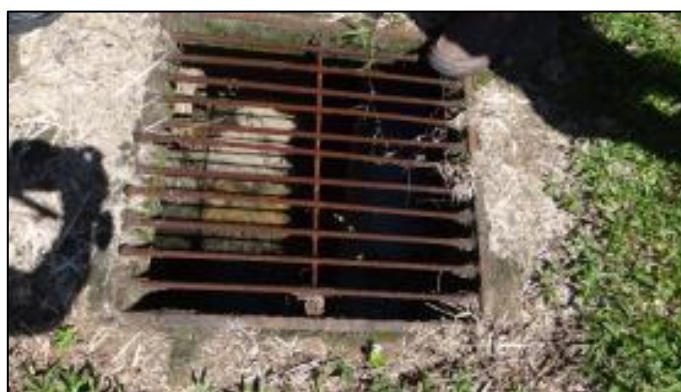
Figura 4: Ponto da rede pluvial dentro da ETE Lagoa da Conceição (14/03/2014)
