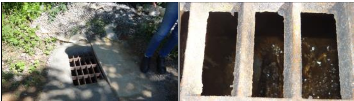
Figura 3: Ponto da rede pluvial em frente a ETE Lagoa da Conceição (14/03/2014)
