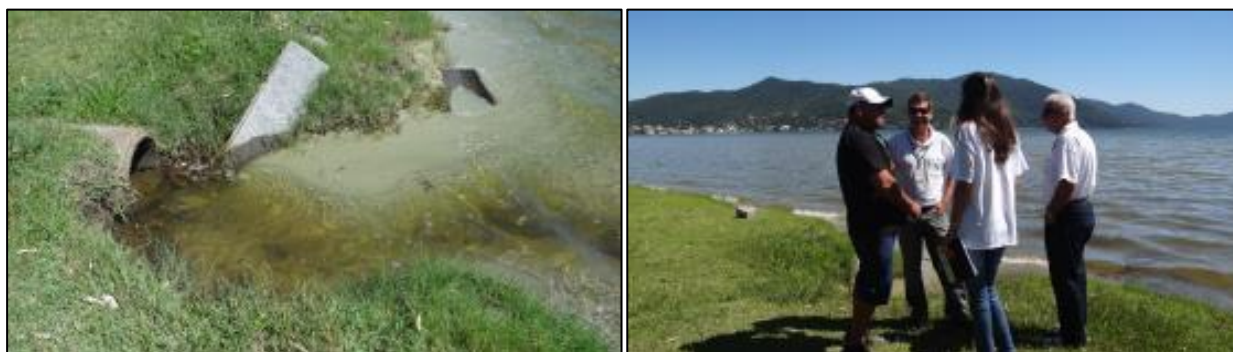
Figura 1: Emissário pluvial que deságua na Lagoa da Conceição (14/03/2014)
