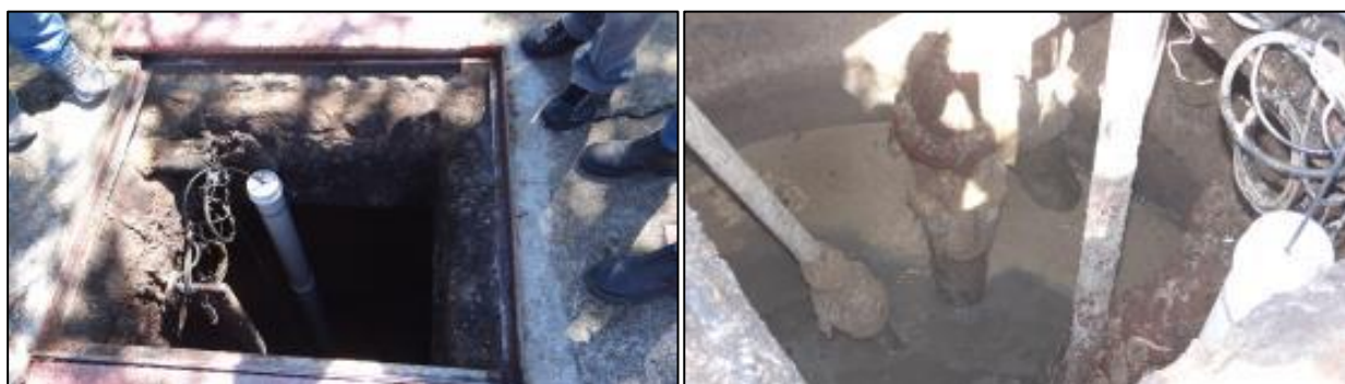
Figura 2: Poço úmido da Estação Elevatória de Esgoto Rendeiras (14/03/2014)
