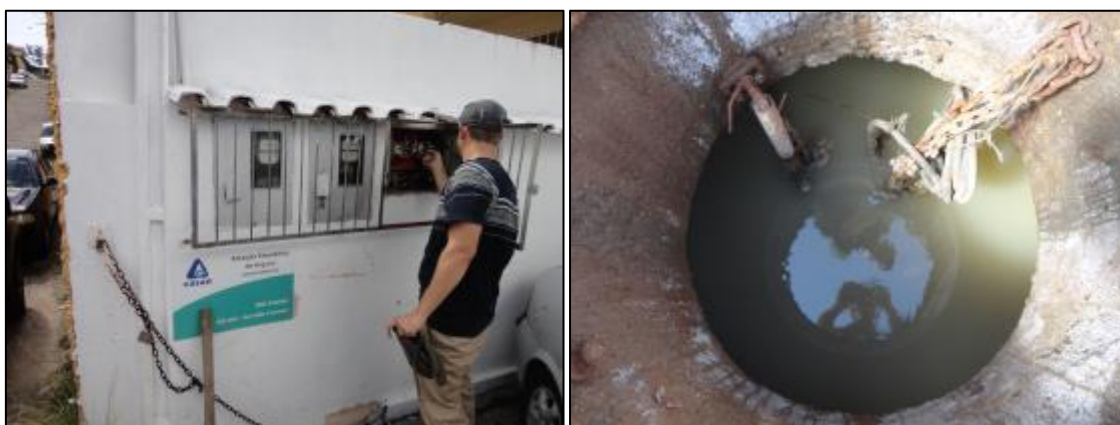
Figura 1: Estação Elevatória de Esgoto BAc Servidão Franzoni inoperante (19/02/2014)
