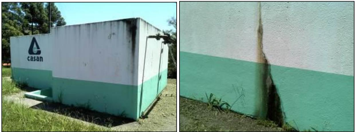
**Figura 5: Fachada da ETA e Rachadura**
