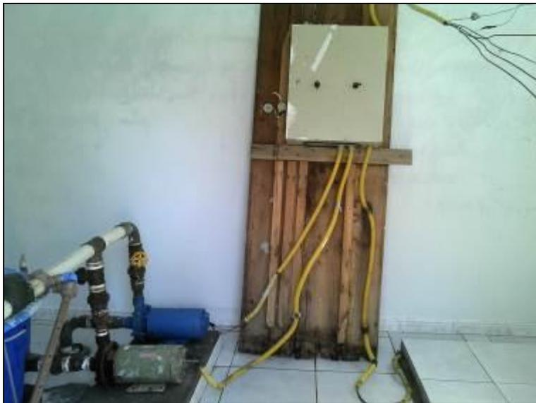
Figura 3: Quadro de comando do Poço
