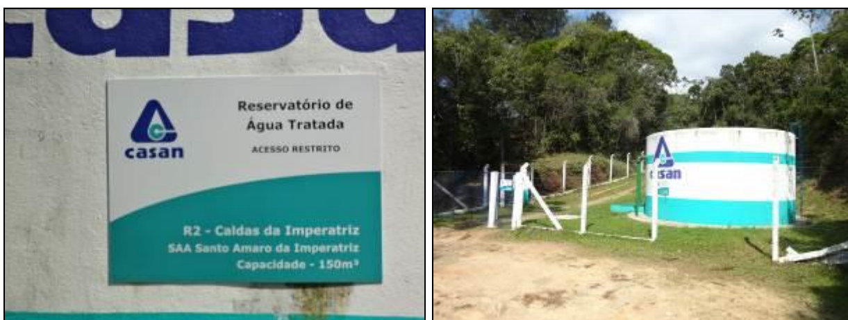
Figura 2: Reservatório de Caldas com pintura e placas
