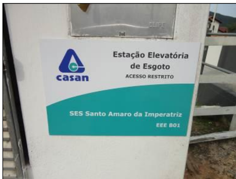
Figura 7: EEE em obras
