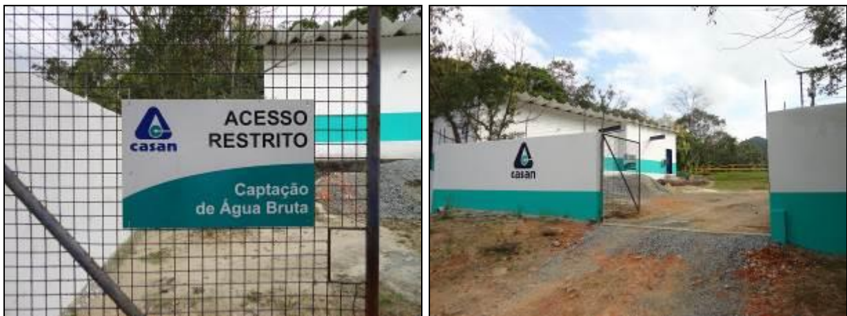
Figura 6: Portão precisa permanecer fechado
