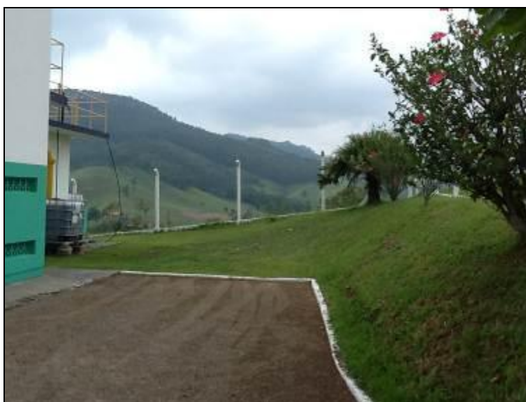
Figura 13: Cercas de proteção
