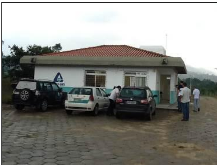
Figura 13: Fachada do Laboratório da ETE
