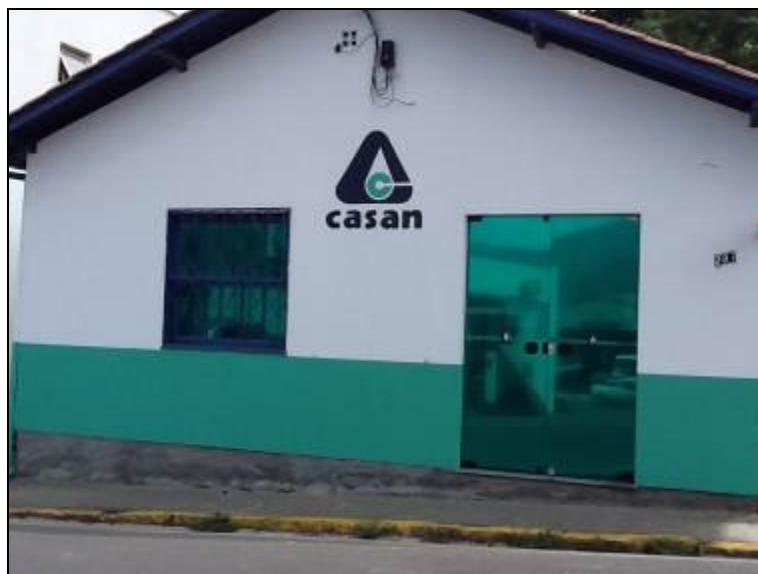
Figura 1: Fachada do Prédio
