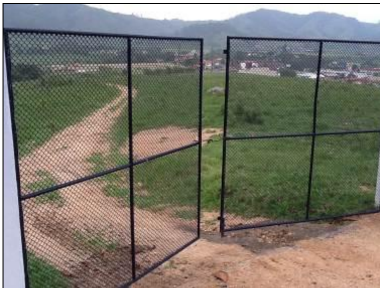
Figura 11: Entrada da Unidade
