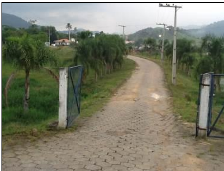
Figura 11 :Acesso a ETE
