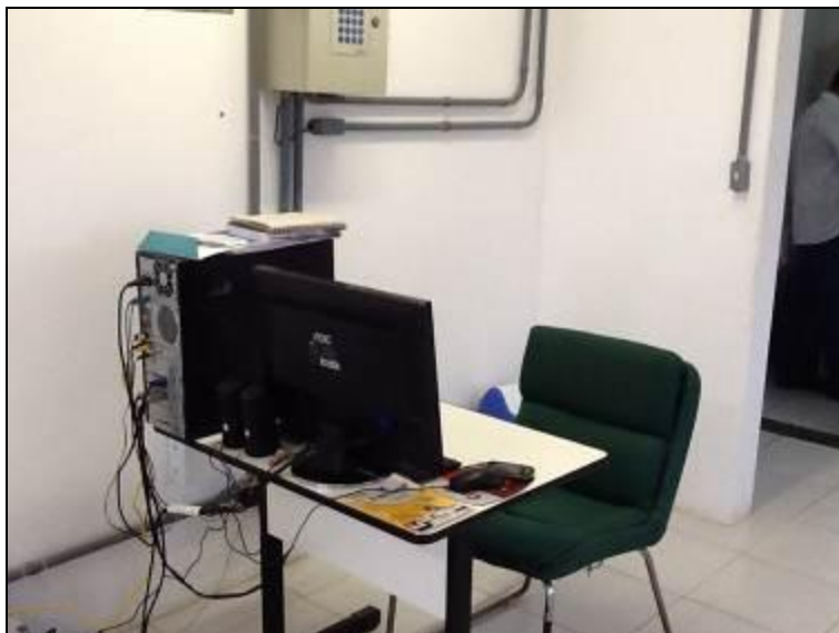
Figura 19: Escritório da ETE
