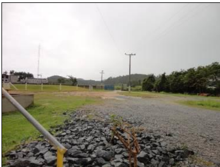
Figura 4: Acesso a Captação (acompanhamento)
