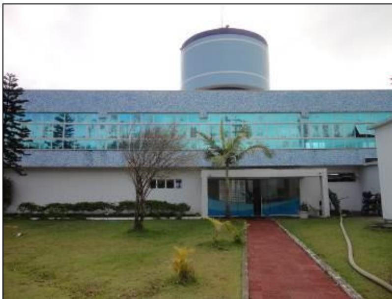
Figura 7: Visão da ETA (acompanhamento)
