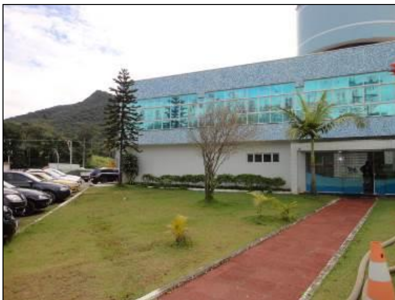
Figura 11: Área de entorno da ETA com Proteção
