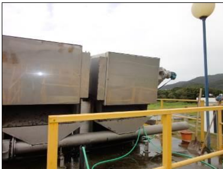
Figura 20: Estrutura de recepção da ETE (acompanhamento)
