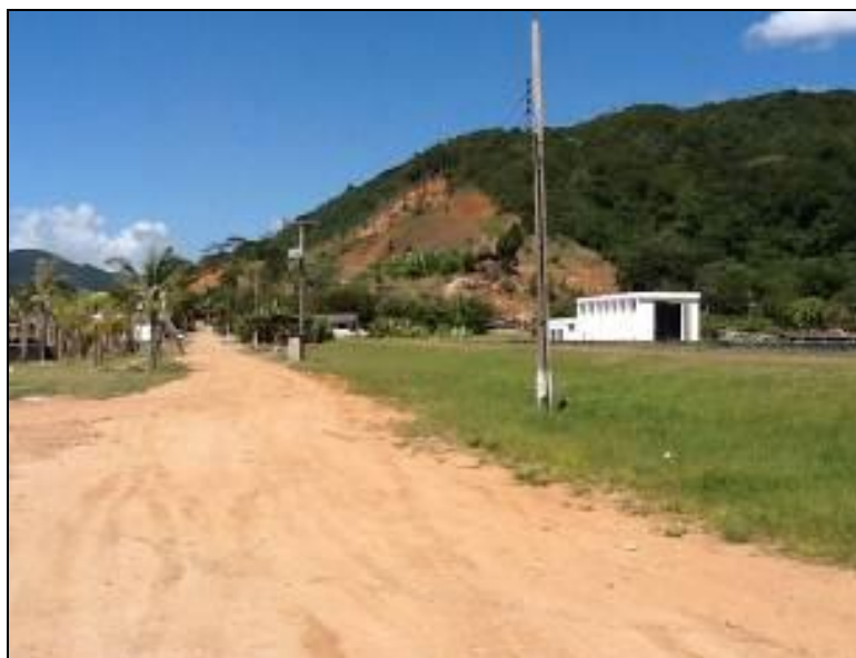
Figura 17: Acesso a ETE (inicial)
