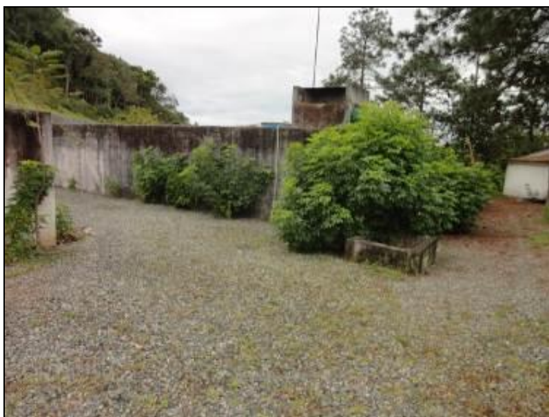
Figura 06: R-01 e os para-raios (acompanhamento)
