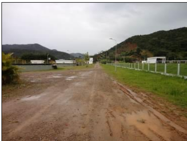
Figura 18: Acesso a ETE (acompanhamento)
