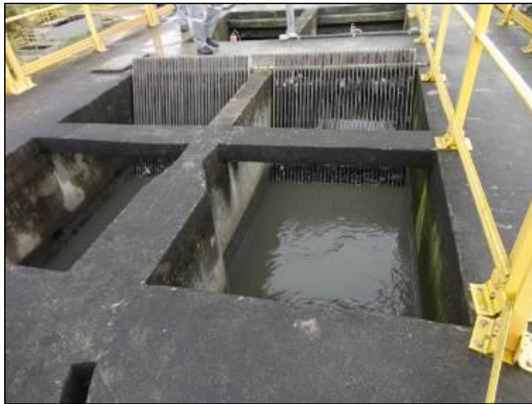
Figura 21: Entrada de efluentes (acompanhamento)
