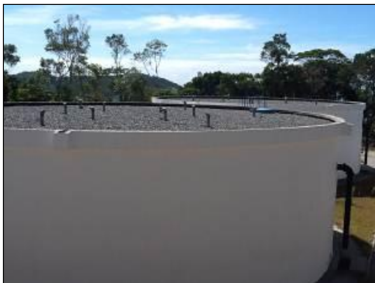
Figura 14: Cobertura do R-03 (acompanhamento)
