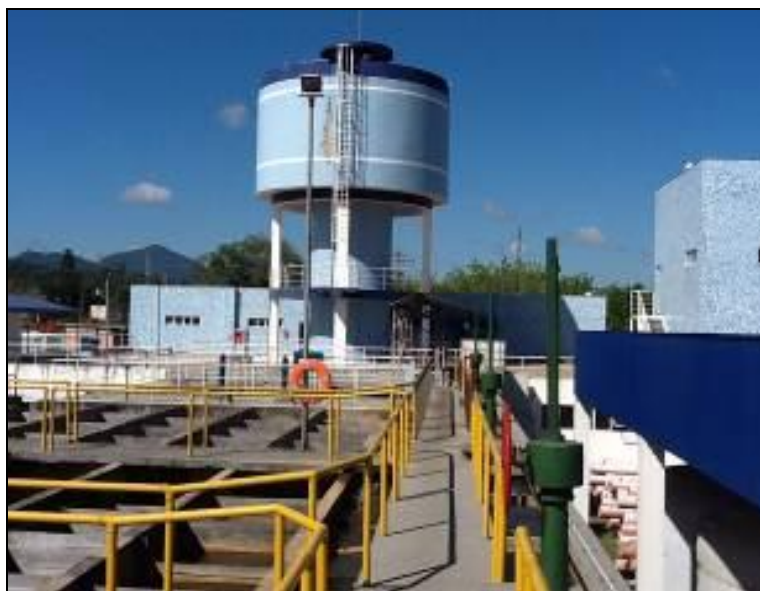
Figura 12: Guarda-corpo ETA (acompanhamento)
