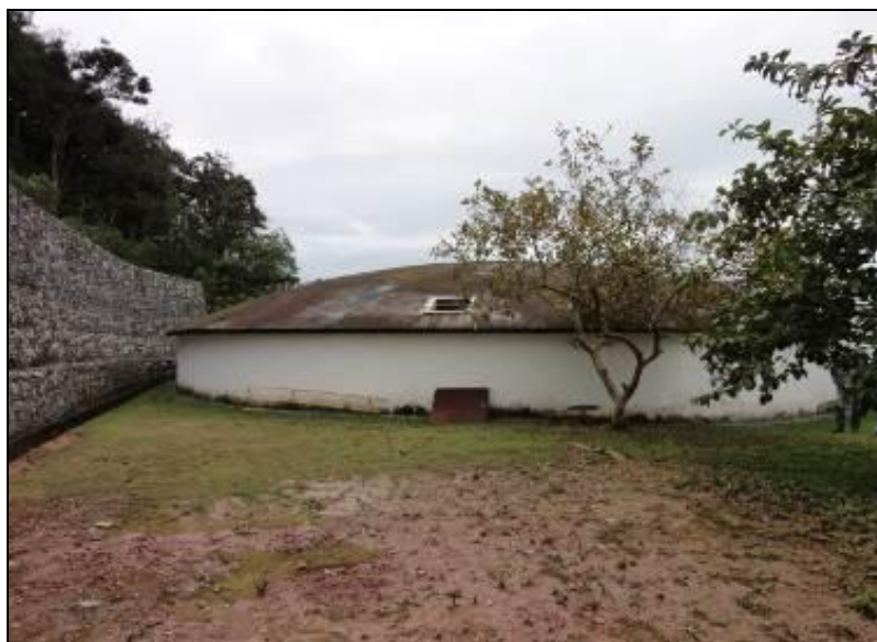
Figura 05: Entorno do R 01 (acompanhamento)
