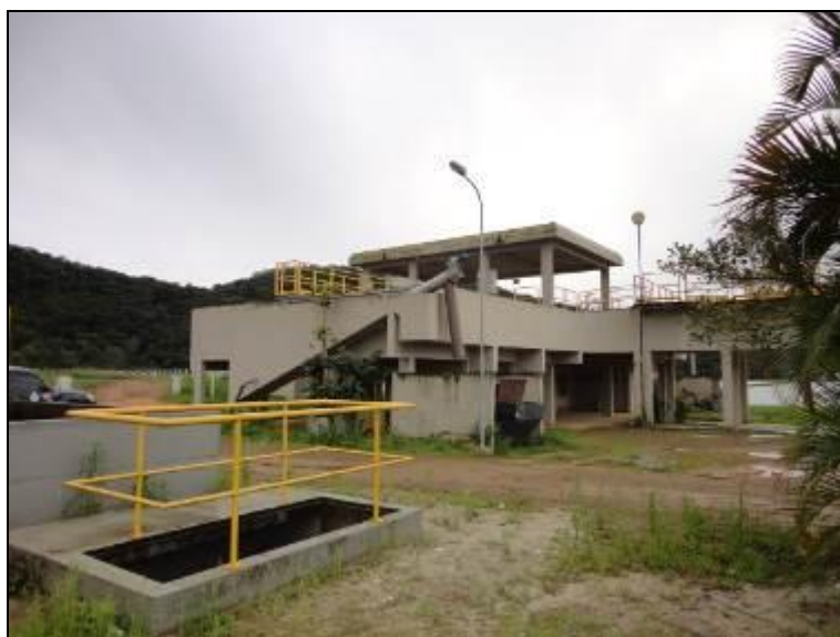
Figura 16: Visão da ETE (acompanhamento)
