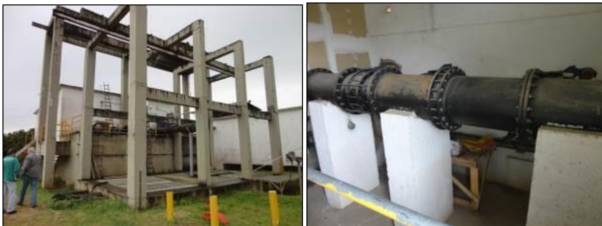
Figura 5: Área Operacional da Captação (acompanhamento)
