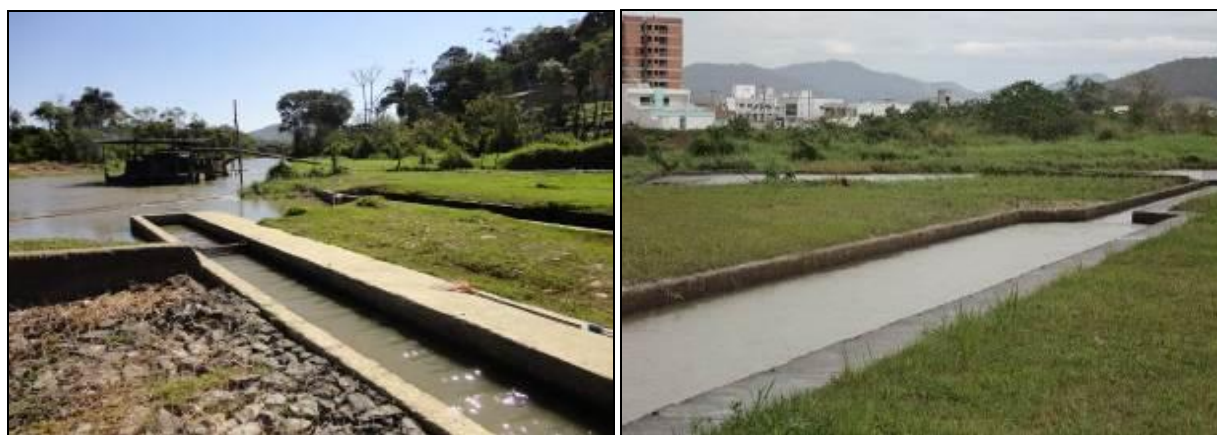
Figura 3: Visão da Captação (inicial e acompanhamento)
