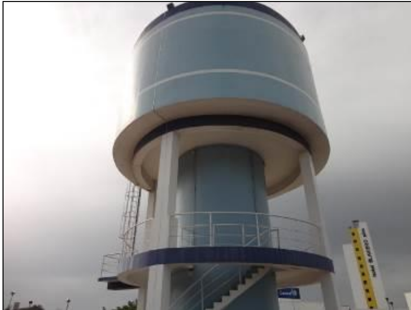
Figura 01 – Reservatório Pulmão Junto a ETA
