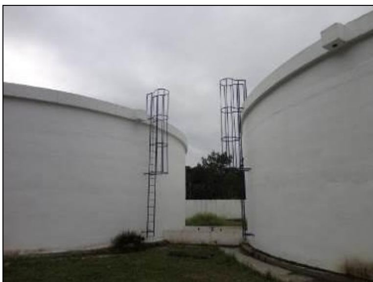
Figura 13: Escadas do R-03 (acompanhamento)
