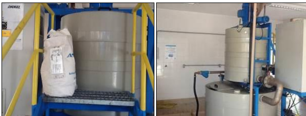
Figura 16: Casa de Química da ETA (inicial)
