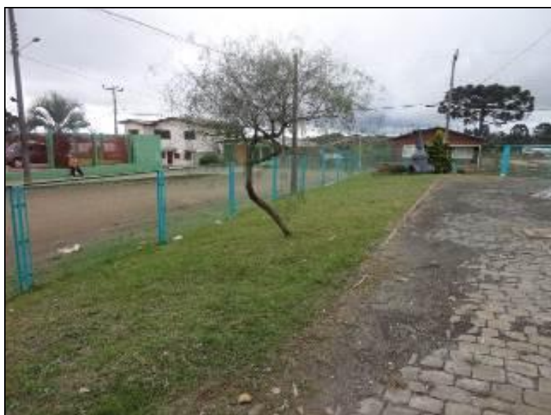
Figura 20: Cercas entorno da ETA. (inicial)
