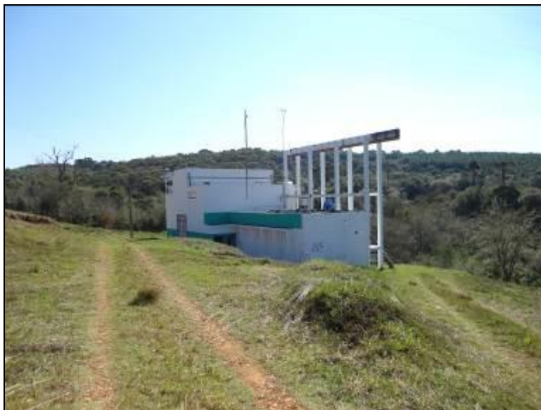
Figura 50: Vista da ERAB (acompanhamento)
