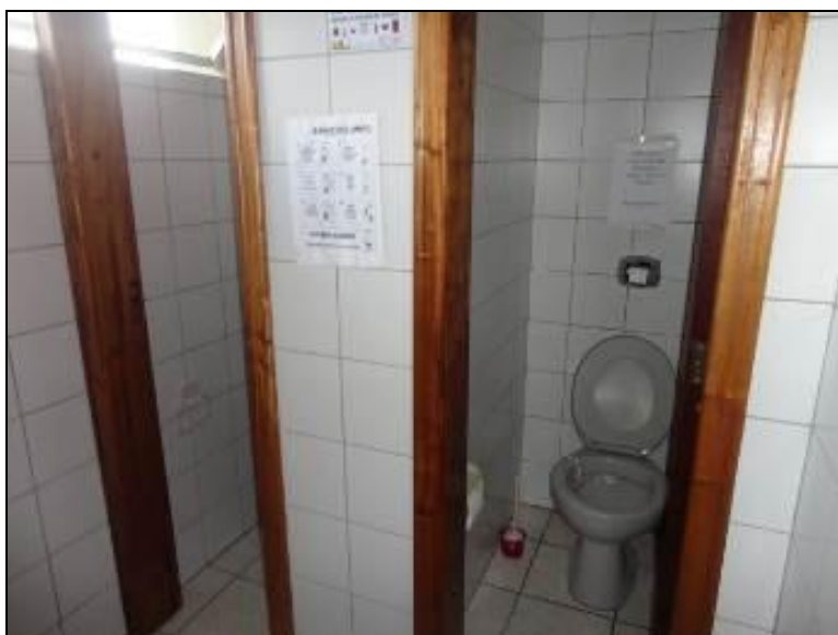
Figura 8: Sanitário do Escritório (inicial)
