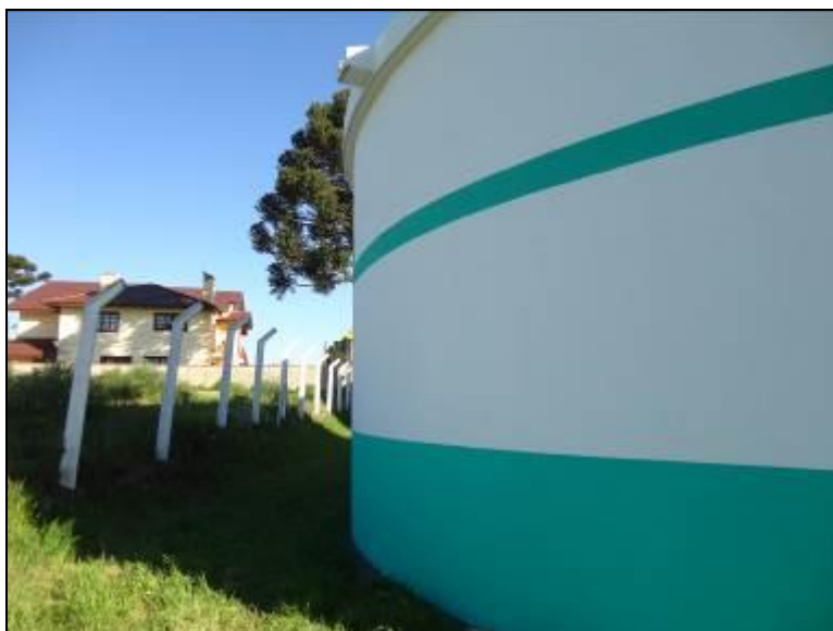
Figura 40: Entorno do Reservatório (acompanhamento)
