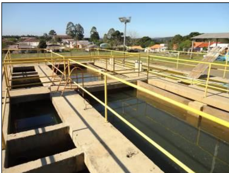
Figura 23: Guarda-Corpo ETA (acompanhamento)
