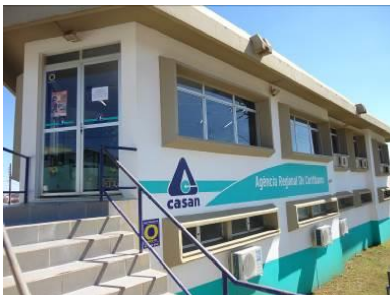
Figura 2: Fachada do Prédio (acompanhamento)
