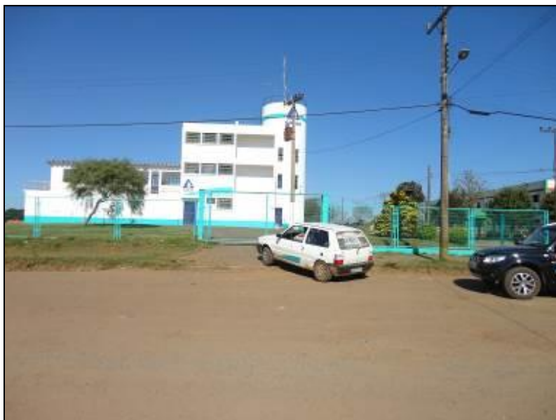
Figura 21: Cerca entorno ETA (acompanhamento)
