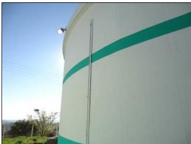
Figura 42: Marcador de nível R 02
