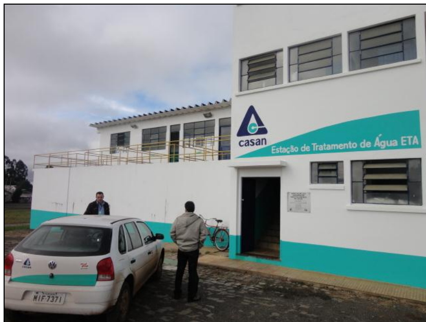
Figura 16: Fachada da ETA (inicial)
