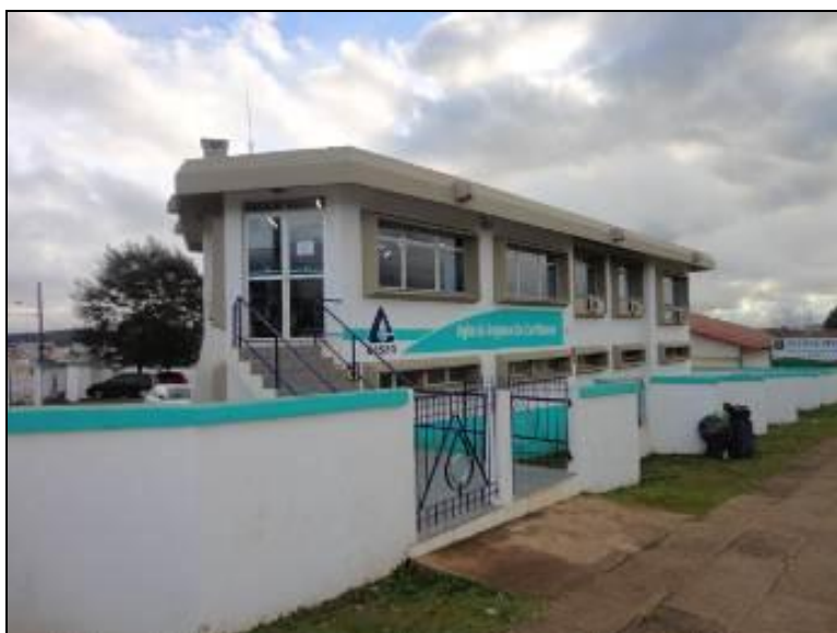
Figura 1: Fachada do Prédio (inicial)
