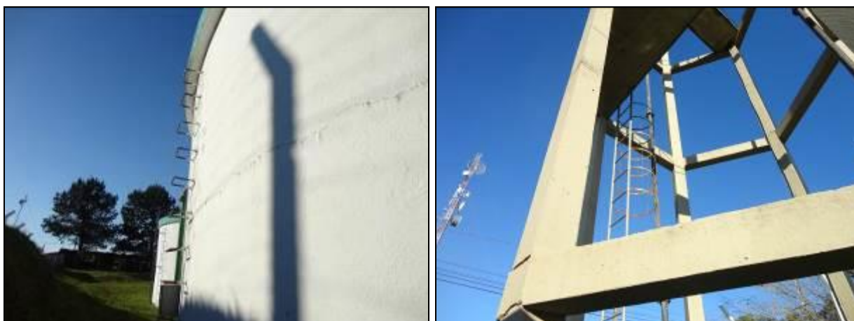
Figura 47: Escada de acesso ao R-03 e R-04 (acompanhamento)
