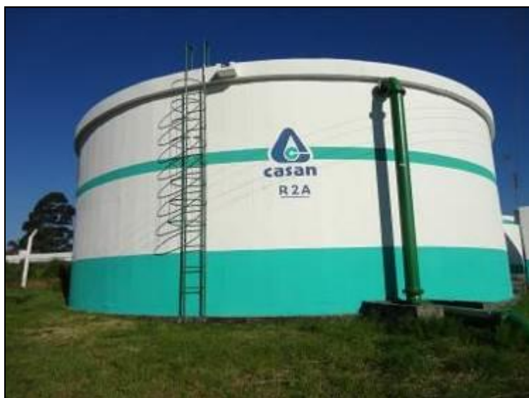
Figura 41: Escada do reservatório (acompanhamento)
