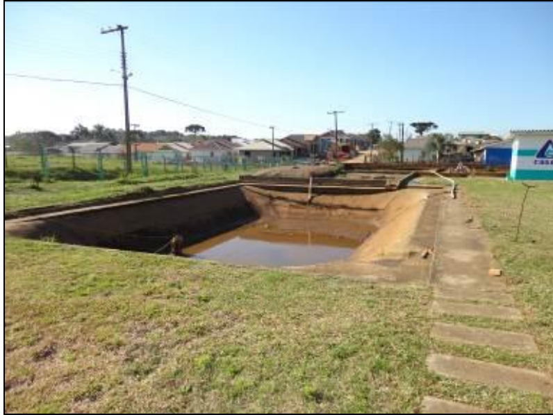
Figura 25: Drenagem do lodo (acompanhamento)
