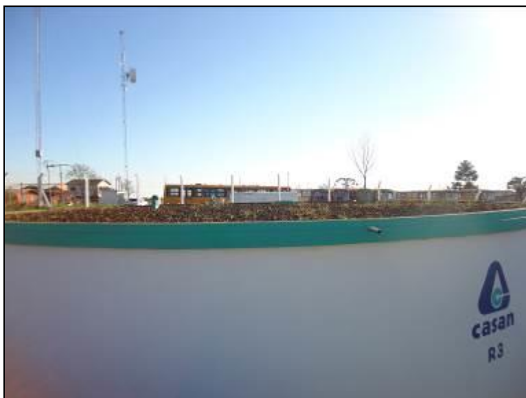
Figura 48: Cobertura e Para-raios do R 03 (acompanhamento)
