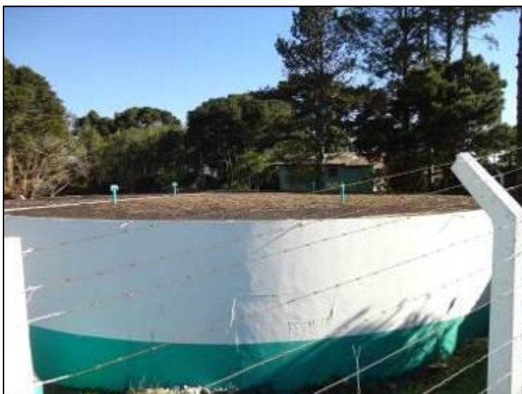
Figura 36: Cobertura do Reservatório (acompanhamento)
