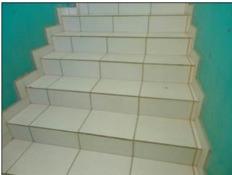
Figura 22: Escada de Acesso ETA (acompanhamento)
