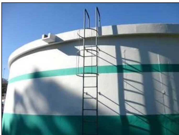
Figura 35: Escada do Reservatório (acompanhamento)
