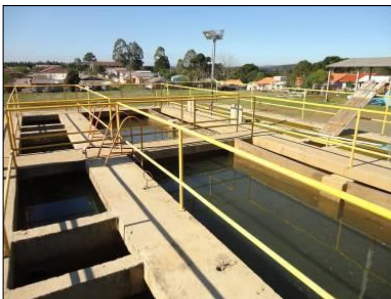
Figura 24: Decantadores ETA (acompanhamento)
