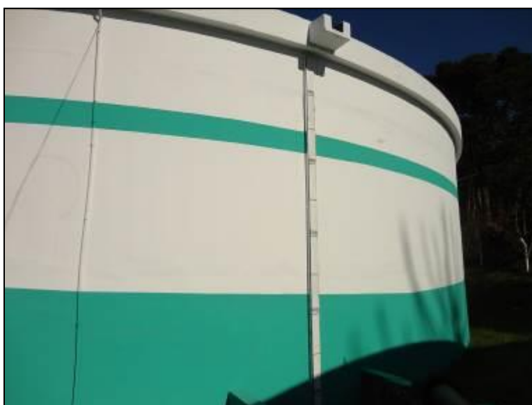
Figura 37: Nível e régua do reservatório (inicial)
