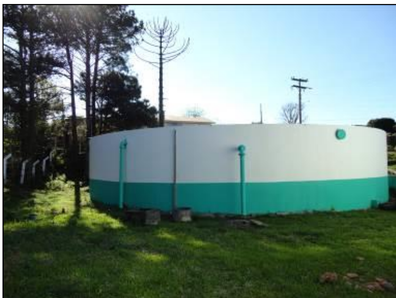
Figura 34: Entorno do reservatório (acompanhamento)
