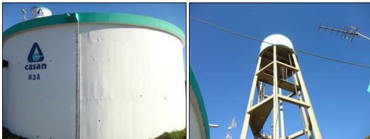
Figura 49: Medidor de nível do R-03 e R-04 (acompanhamento)
