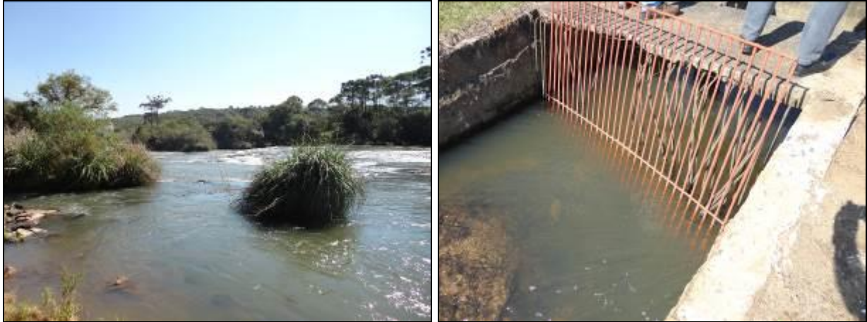
Figura 12: Área do manancial onde é feita a captação (acompanhamento)
