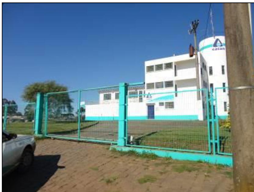
Figura 17: Fachada da ETA (acompanhamento)
