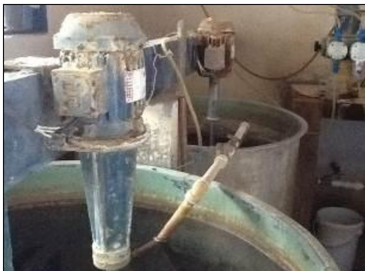
Figura 24: Casa de Química da ETA (inicial)
