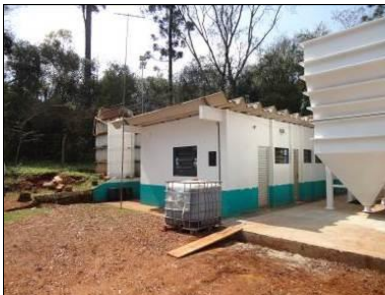
Figura 16: Fachada da ETA (acompanhamento)
