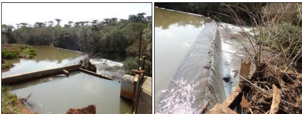
Figura 12: Captação, represa e barragem Rio Bonito (acompanhamento)
