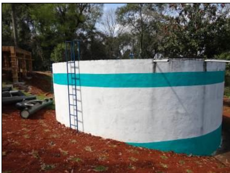
Figura 30: Escada do Reservatório (acompanhamento)
