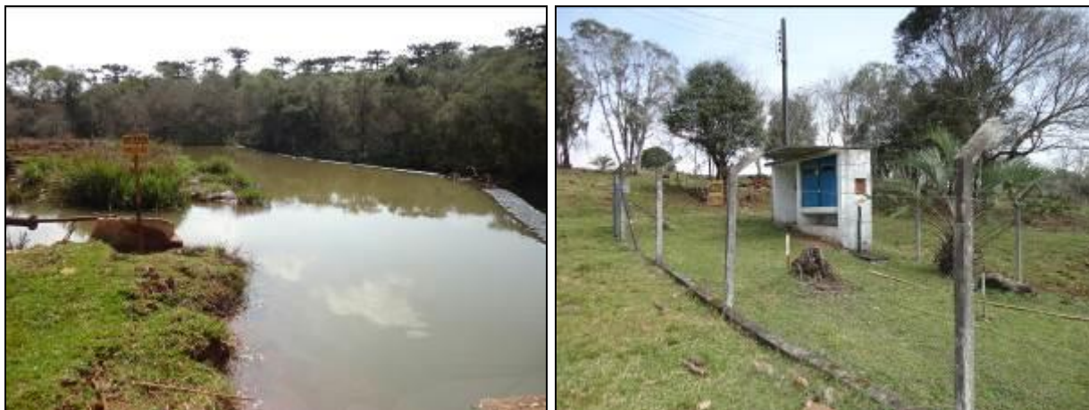
Figura 15: Área do manancial sem isolamento e identificação
