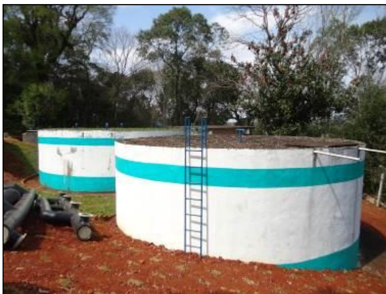
Figura 31: Cobertura do Reservatório (acompanhamento)
