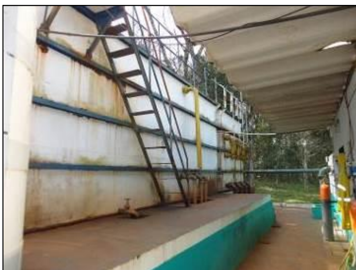
Figura 19: Escada de acesso a ETA e guarda corpo (acompanhamento)
