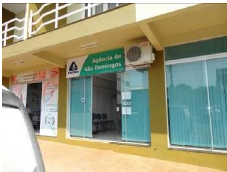
Figura 2: Fachada do Escritório (acompanhamento)
