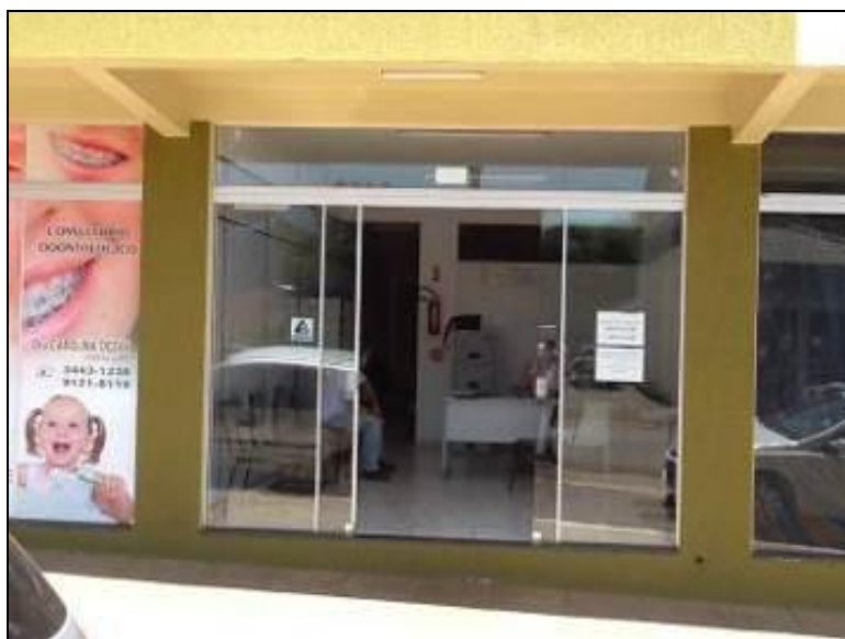
Figura 1: Fachada do Escritório (inicial)
