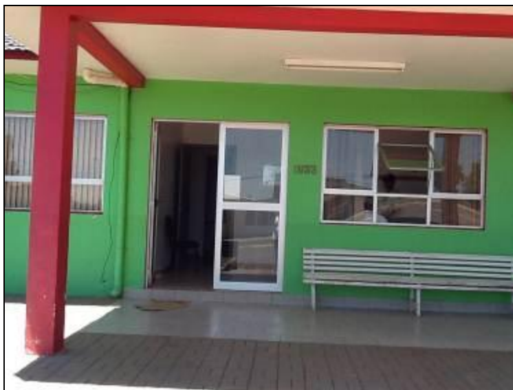
Figura 1 – Fachada do Prédio
