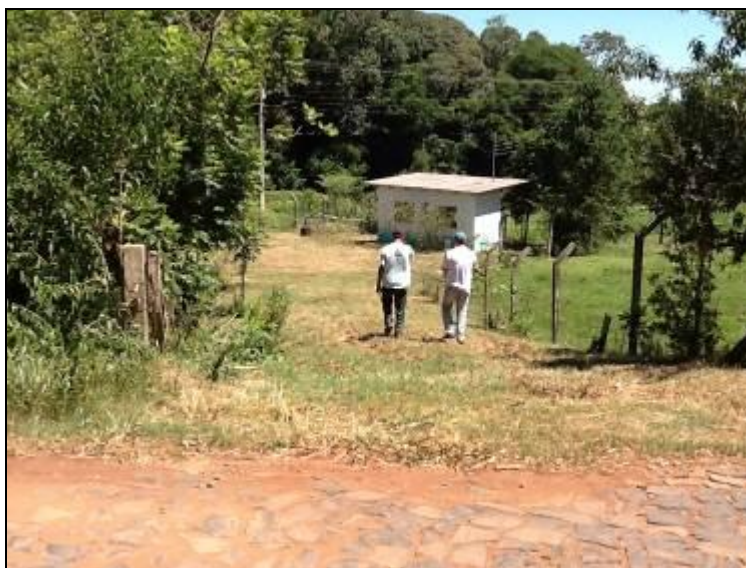
Figura 8: Acesso a Casa de Química
