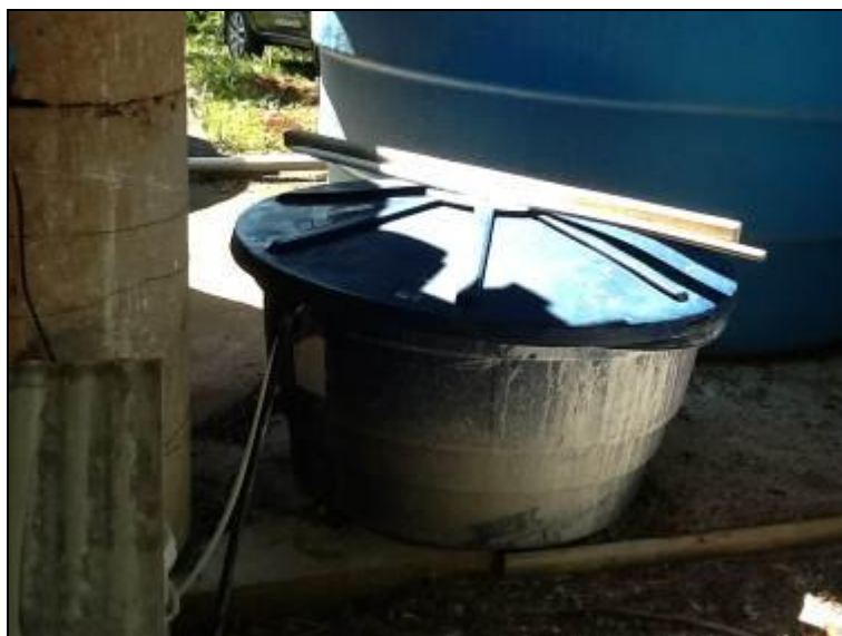
Figura 13: Enjambrações nas estruturas.
