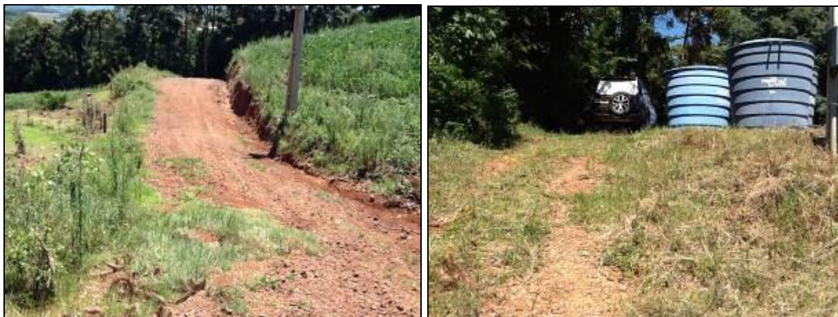
Figura 11: Acesso aos reservatórios
