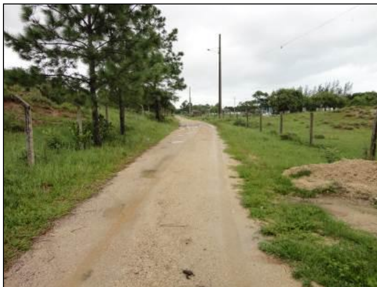
Figura 7: Acesso à Captação/ETA
