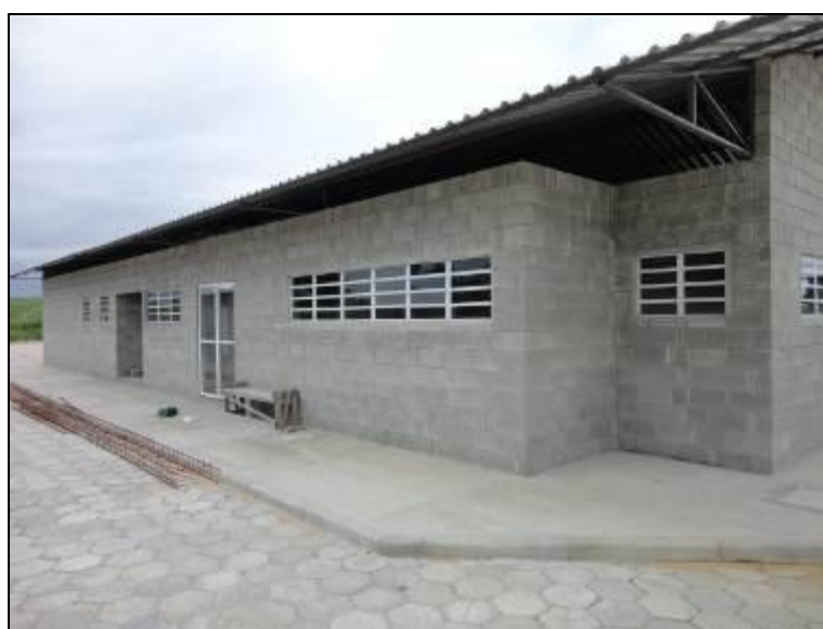
Figura 12: ETE em construção
