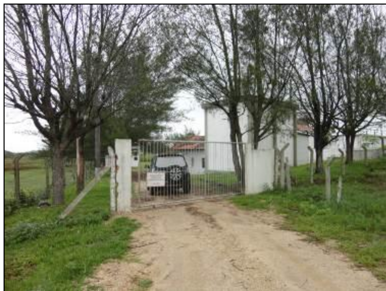
Figura 8: Fachada da ETA
