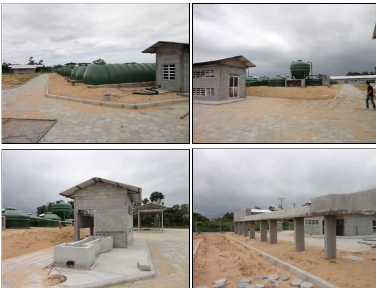
Figura 28: Outras imagens da ETE em construção.
