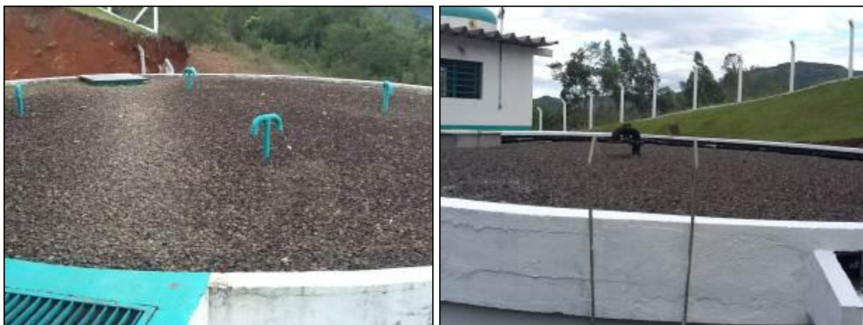
Coberturas dos Reservatórios.
