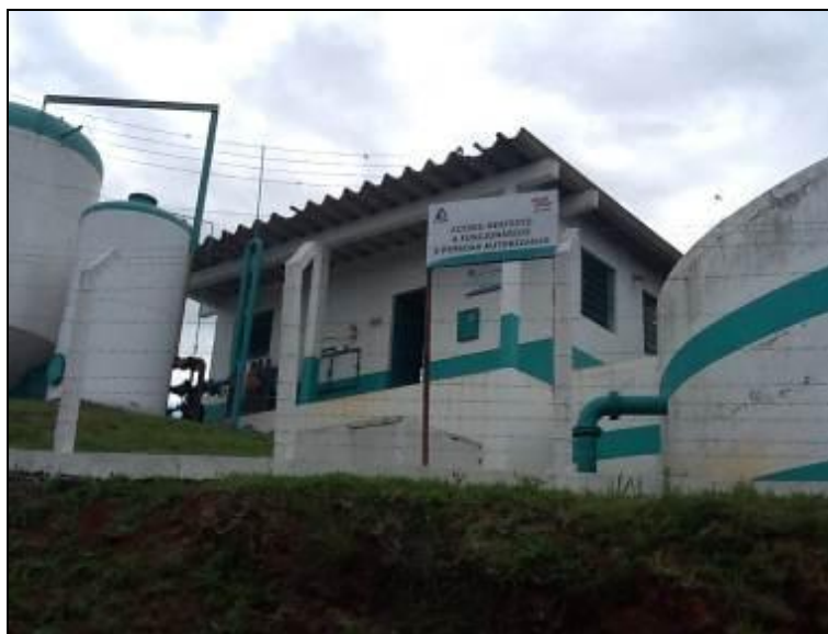
Fachada da ETA.
