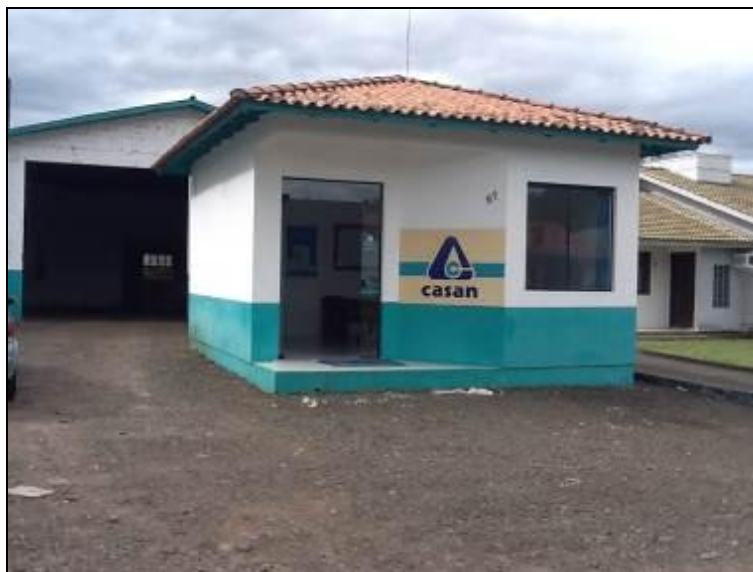
Fachada do Escritório.
