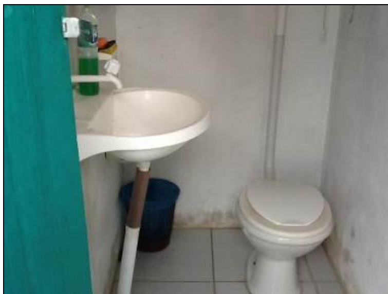
Sanitário do Escritório.
