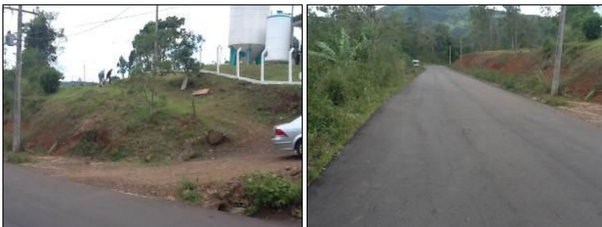
Acesso e entrada da ETA
