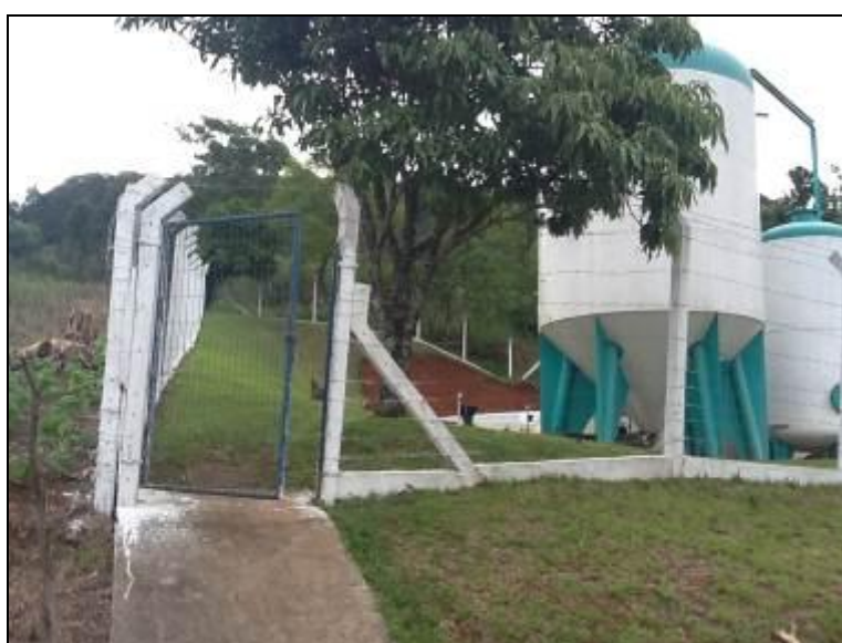
Estado de conservação das áreas externas.
