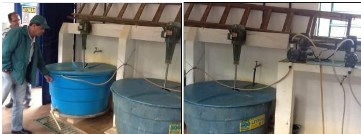
Casa de Química da ETA.
