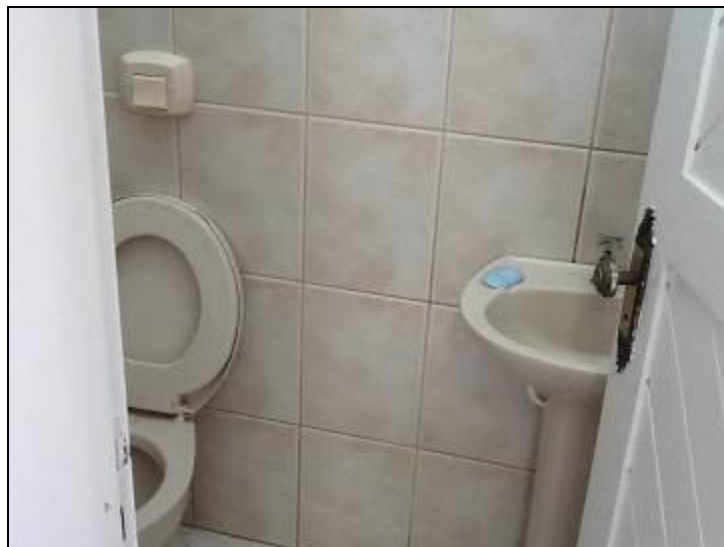
Figura 5: Sanitário da Agência
