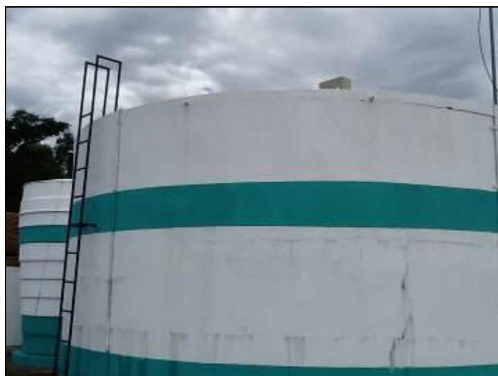
Figura 14: Escada de acesso.
