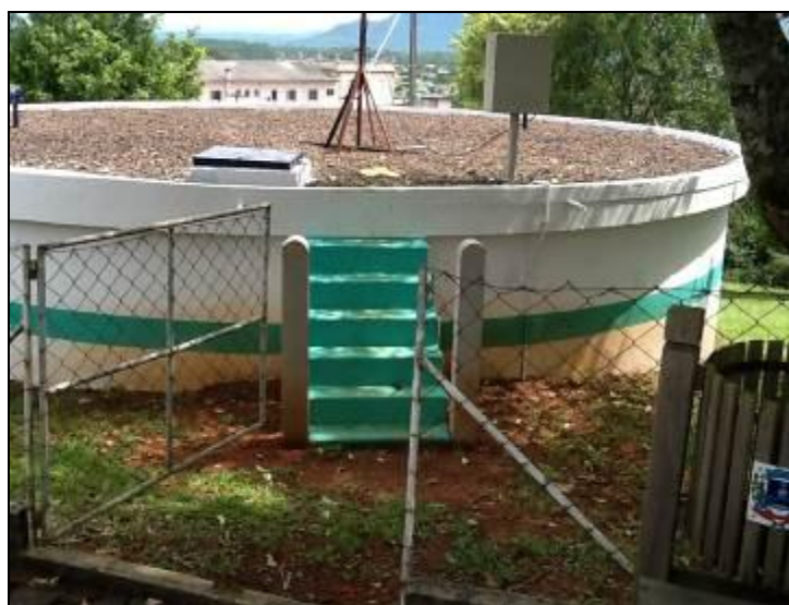
Figura 11: Escada e cobertura em boas condições.
