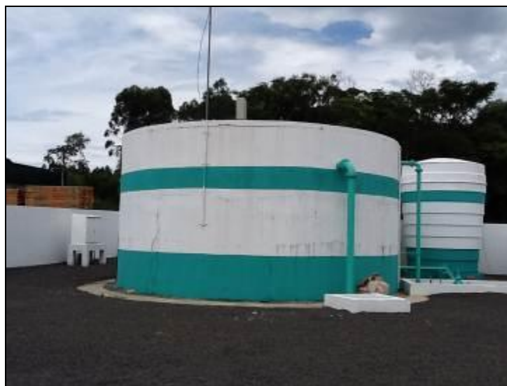
Figura 13: Entorno dos Reservatórios
