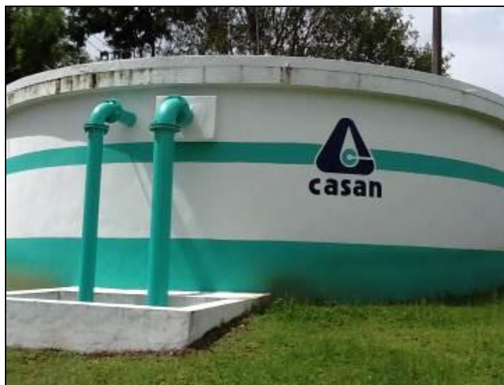
Figura 8: Reservatório do Morro do Hospital - Centro
