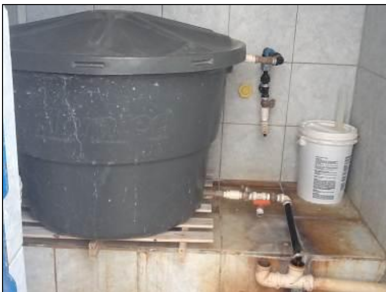
Casa de Química da ETA.
