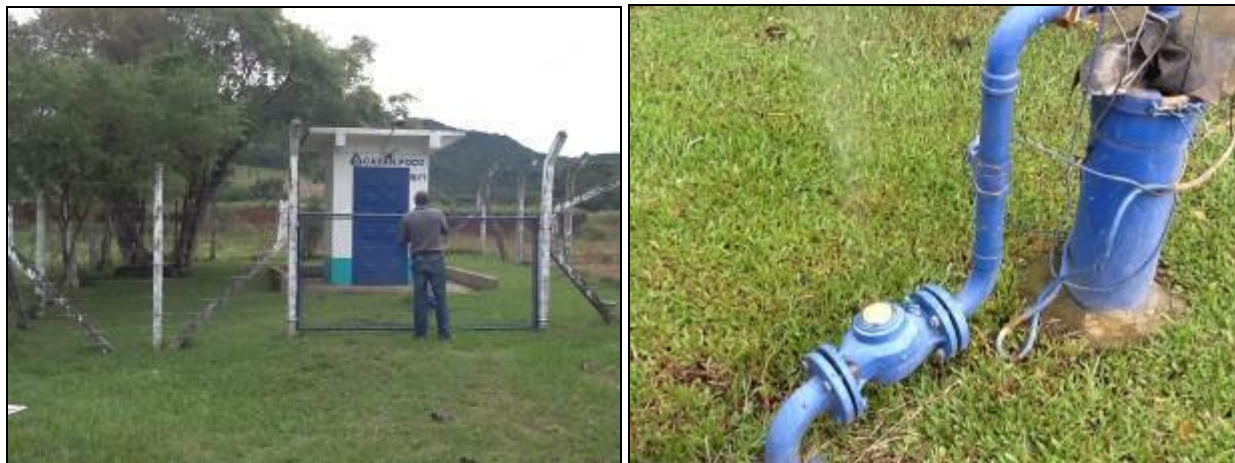
Área do manancial onde é feita a captação.
