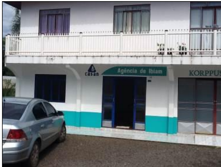
Fachada do Escritório.
