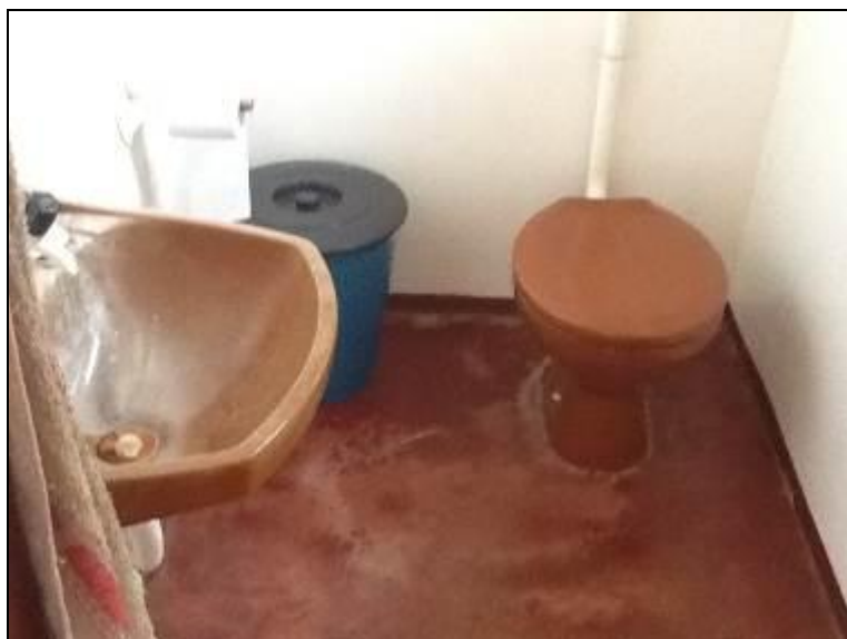
Sanitário do Escritório.
