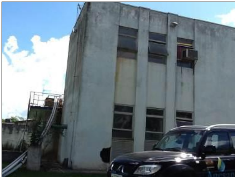
Figura 9: Fachada da ETA
