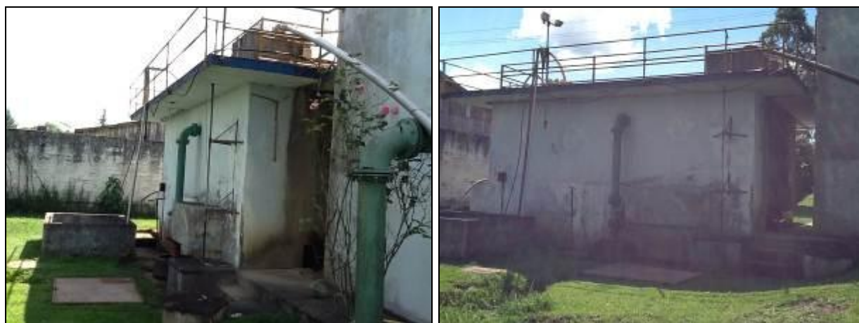
Figura 12: Áreas externas da Estação.
