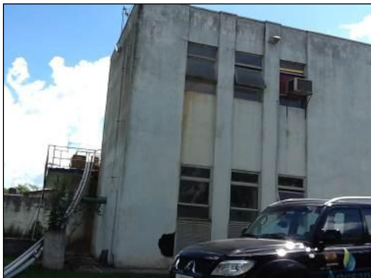
Figura 9: Fachada da ETA
