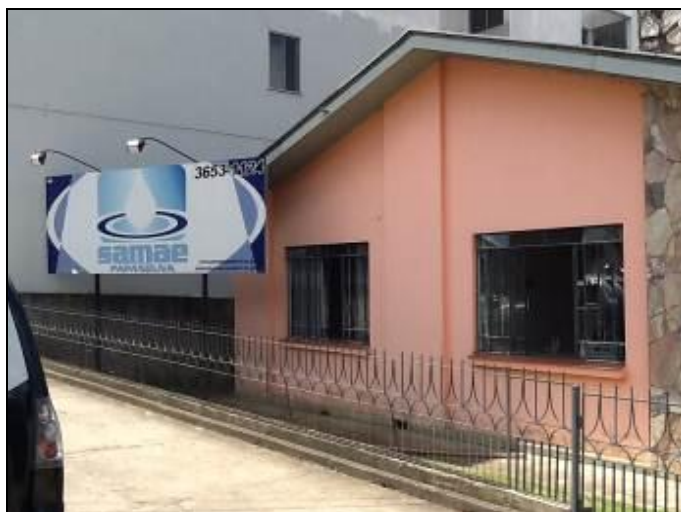
Figura 1: Fachada do Escritório Local
