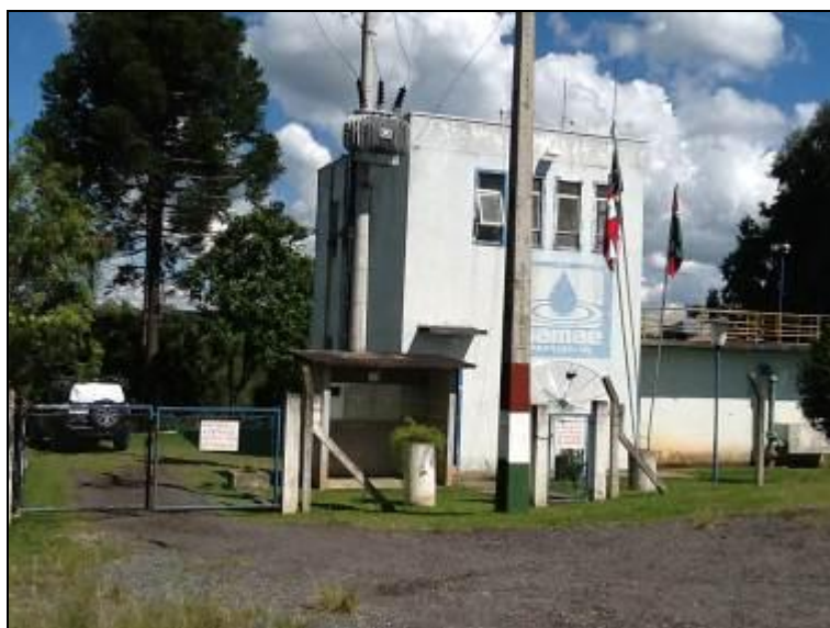
Figura 11: Vista Geral da ETA
