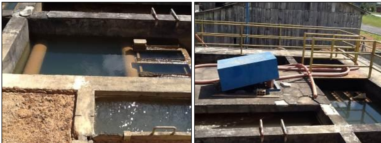
Figura 13: Estruturas de tratamento físico.
