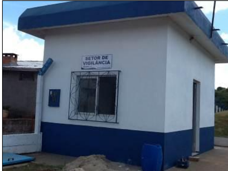
Edificação de apoio
