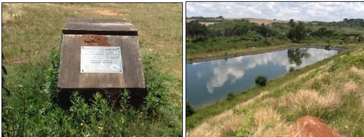
Estação de tratamento de Esgotos secundária.
