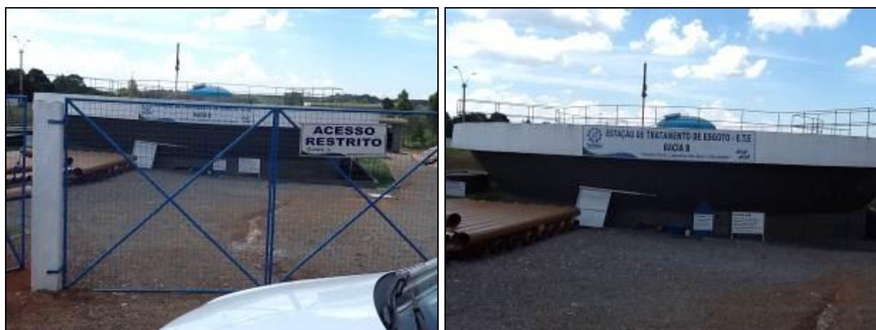
Fachada da ETA Central
