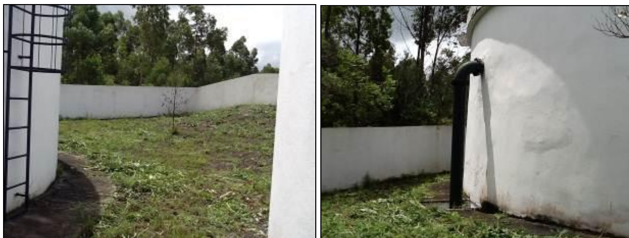
Figura 25: Entorno dos Reservatórios.
