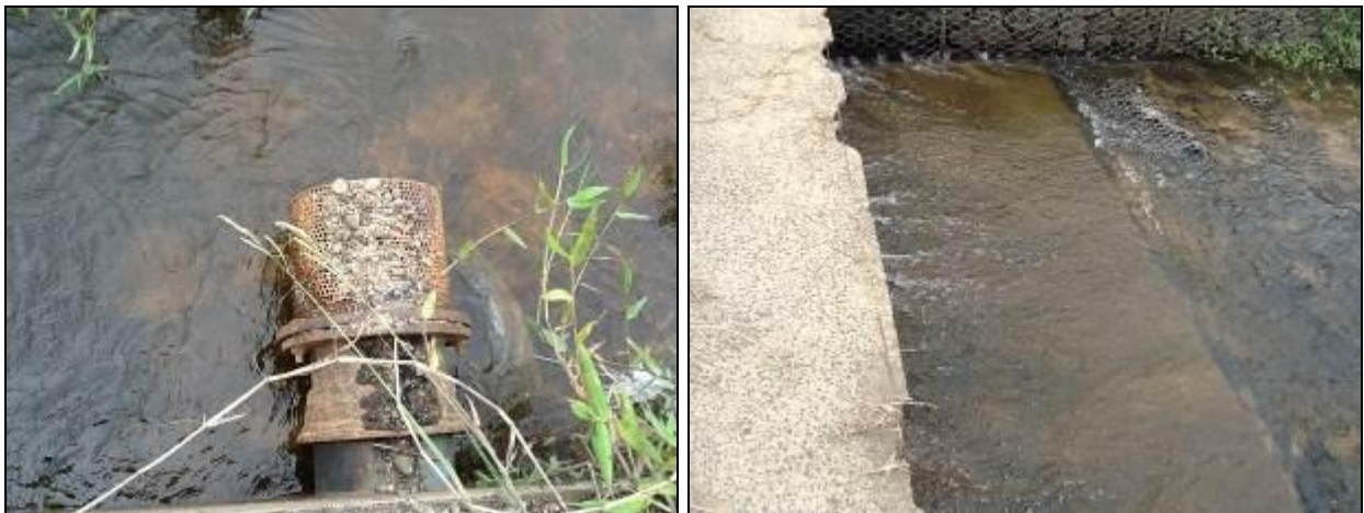
Figura 8: Crivo e barragem da captação.
