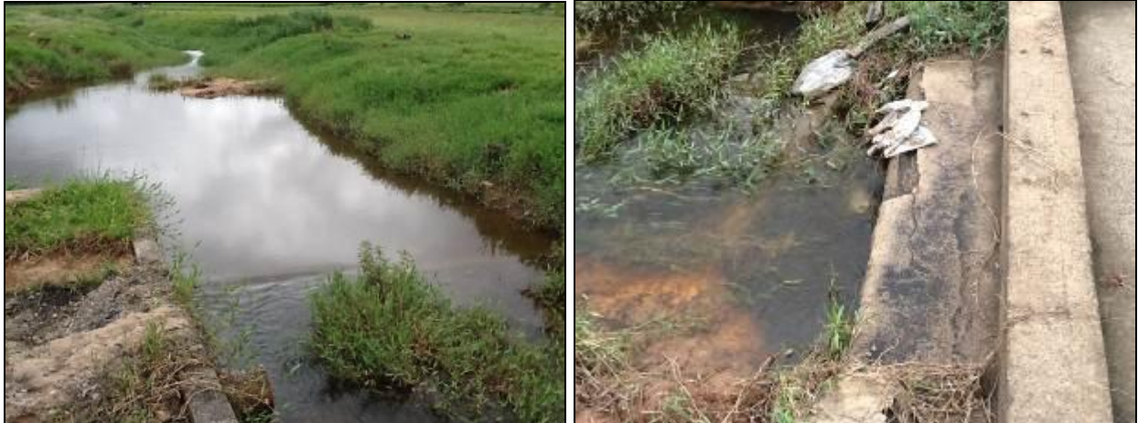
Figura 7: Captação Rio Vargedo.
