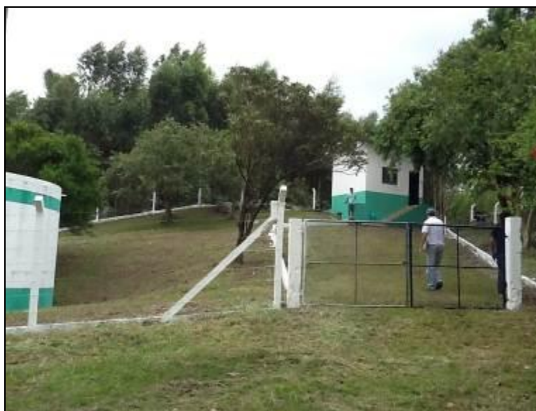
Figura 19: Acesso à ETA.
