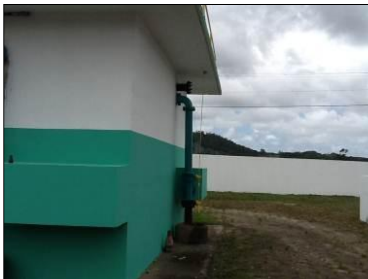
Figura 12: Muro de contorno da ETA
