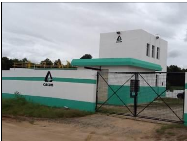
Figura 10: Fachada da ETA
