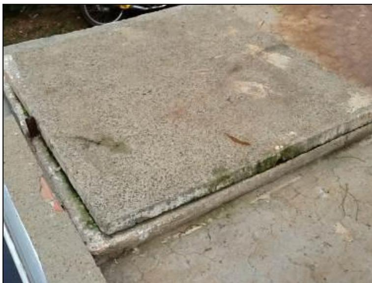
Instrumentos possuem tampas: Câmara de contato
