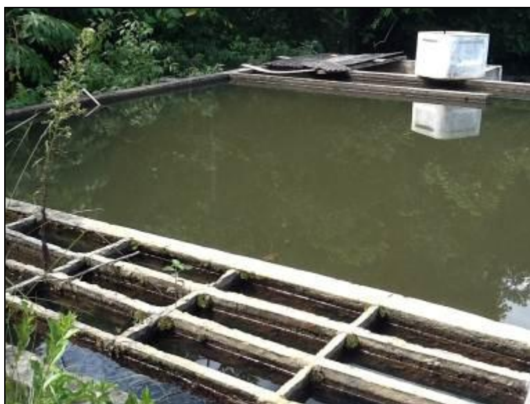
Figura 8: Estruturas de tratamento físico.
