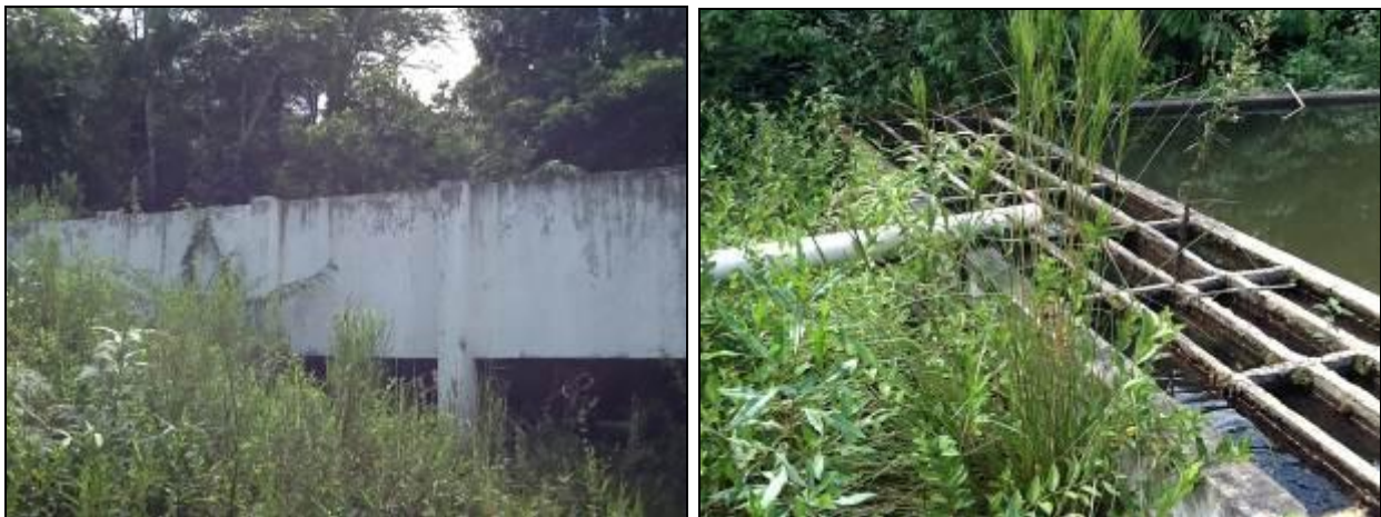
Figura 5: Área de captação do Rio Cocal.
