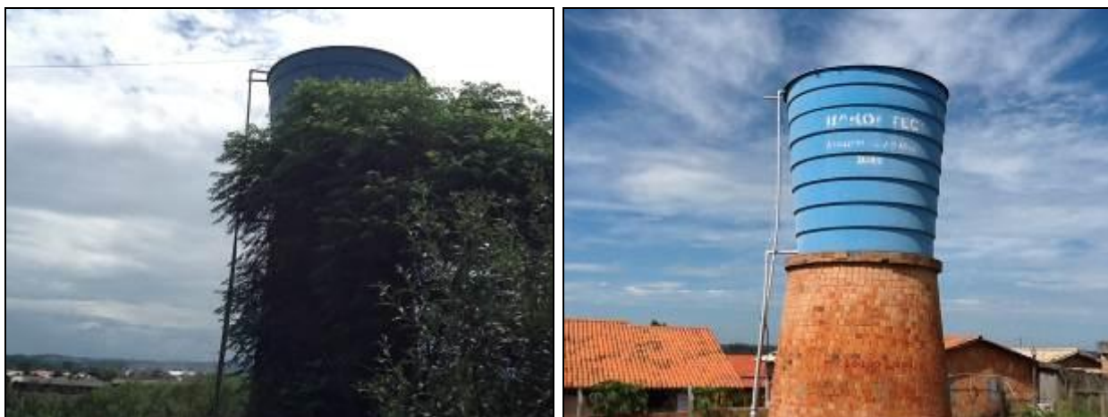
Figura 9: Reservatórios disponíveis no SAA de Sangão.
