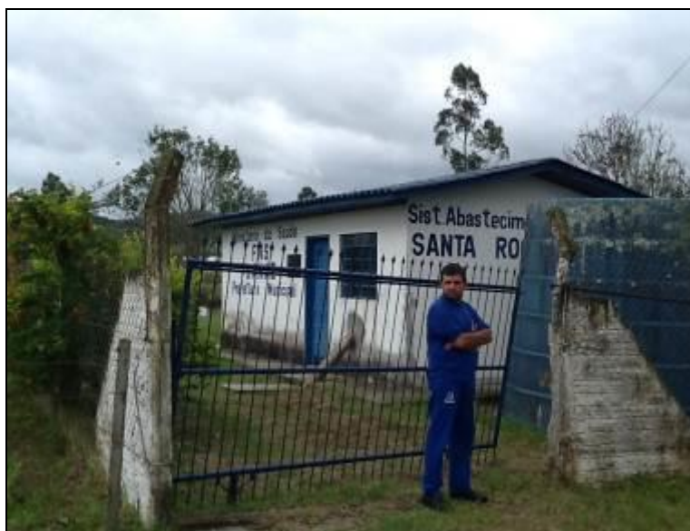
Figura 6: Entrada da Casa de Química.
