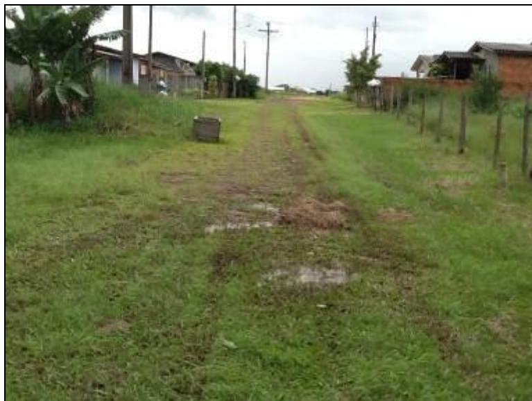
Figura 4: Estrada de Acesso.
