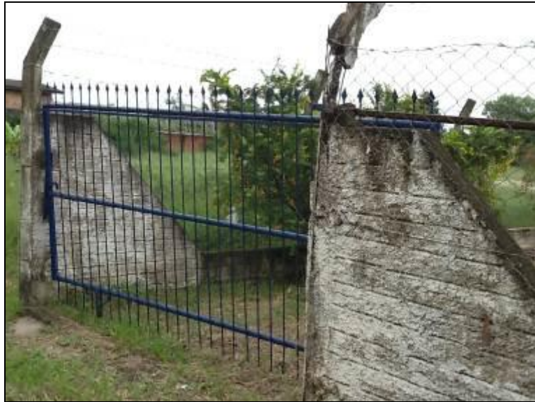
Figura 3: Entrada da área de captação.
